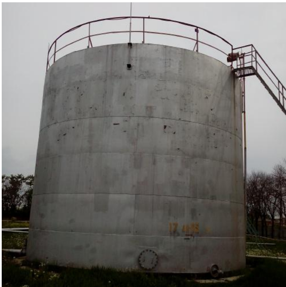
Рисунок 1 - Общий вид резервуара стального вертикального цилиндрического РВС-700
