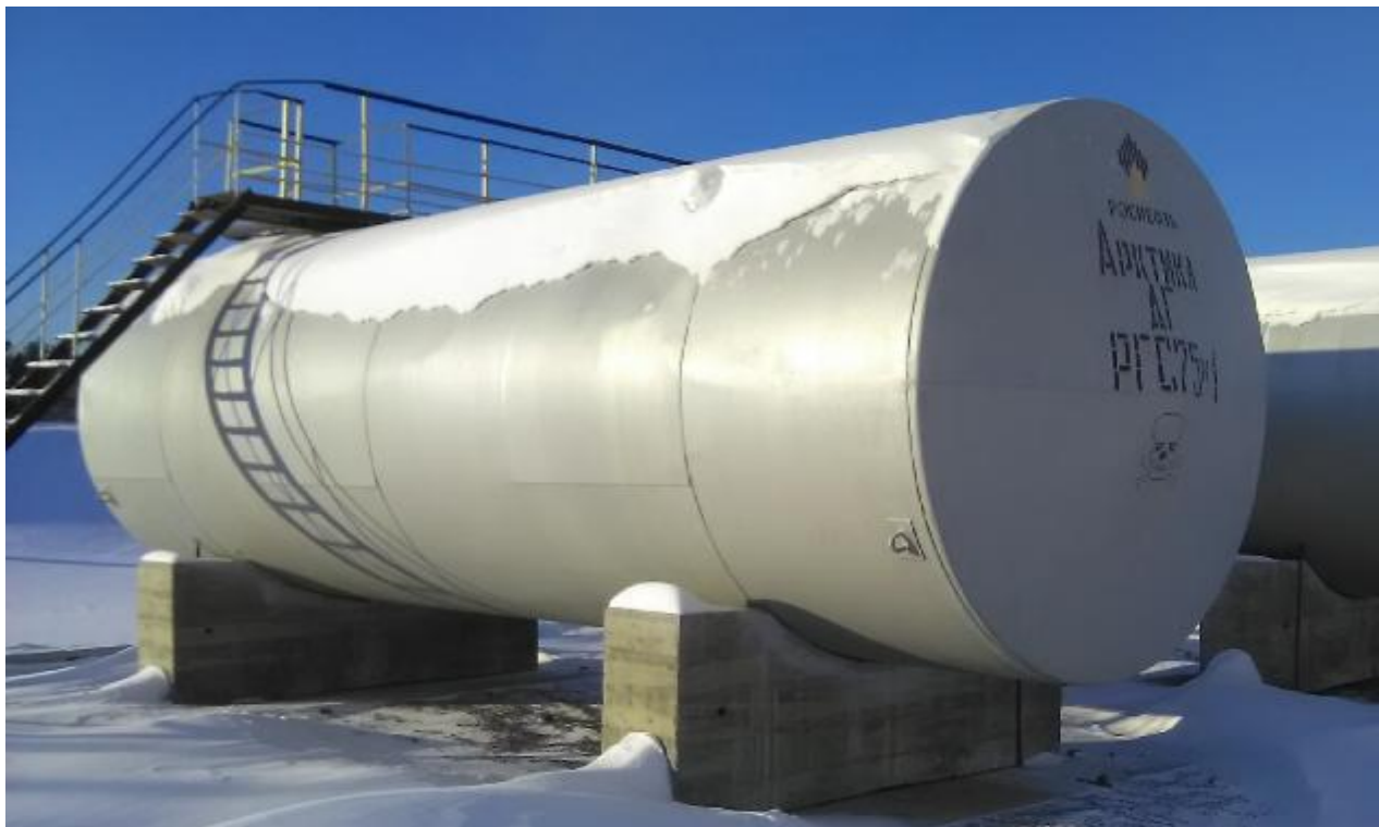
Рисунок 2 - Общий вид резервуара стального горизонтального цилиндрического РГС-75
