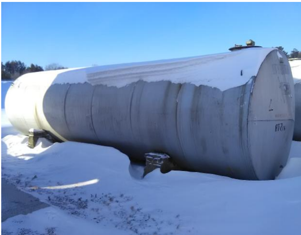
Рисунок 1 - Общий вид резервуара стального горизонтального цилиндрического РГС-60
