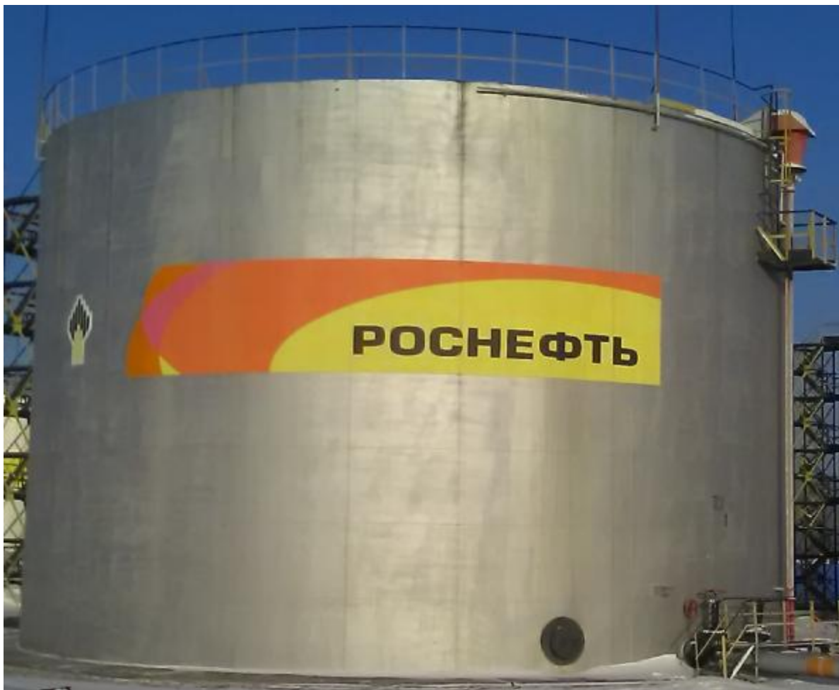
Рисунок 1 - Общий вид резервуара стального вертикального цилиндрического РВС-3000
