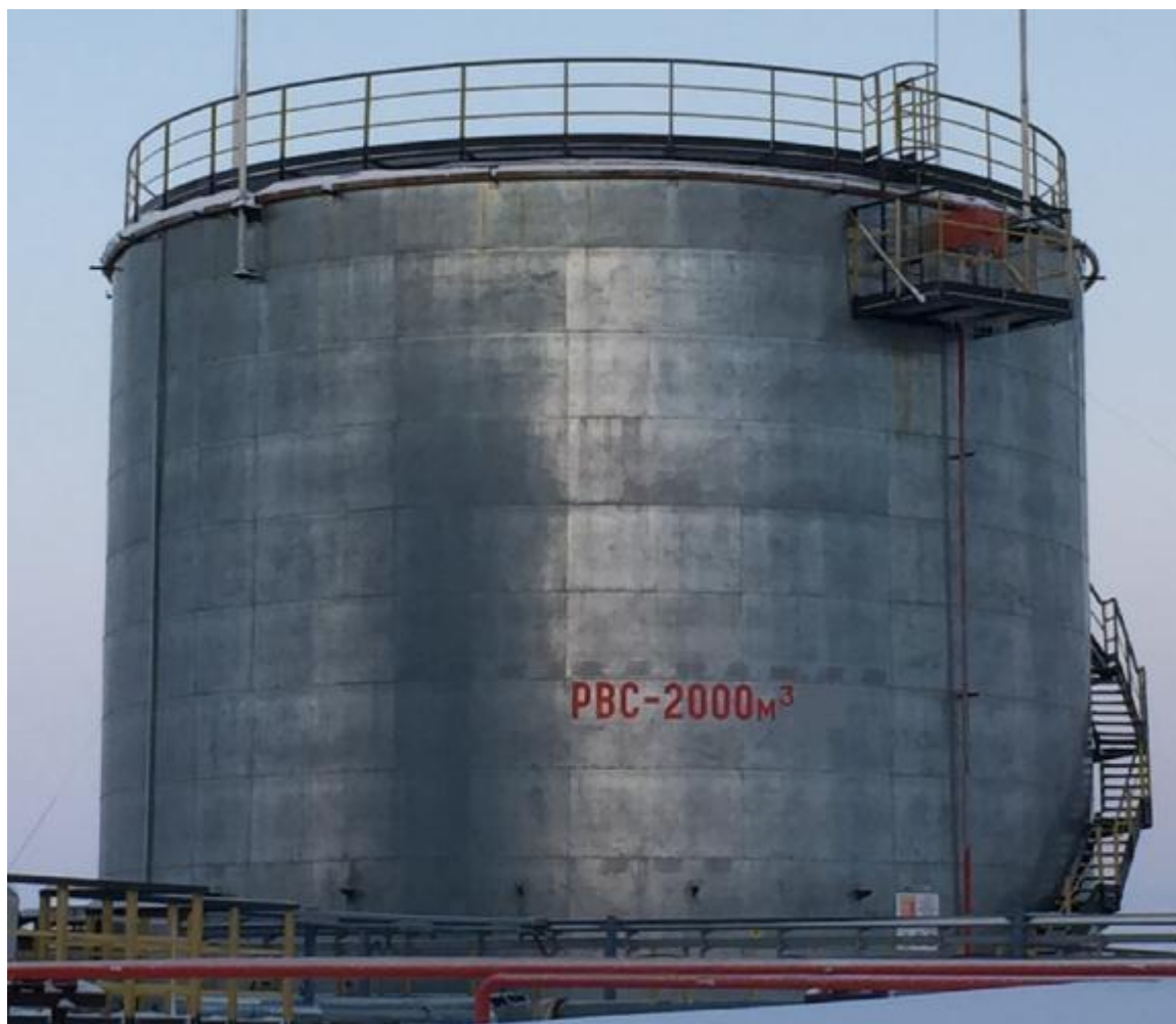
Рисунок 1 - Общий вид резервуара стального вертикального цилиндрического РВС-2000
