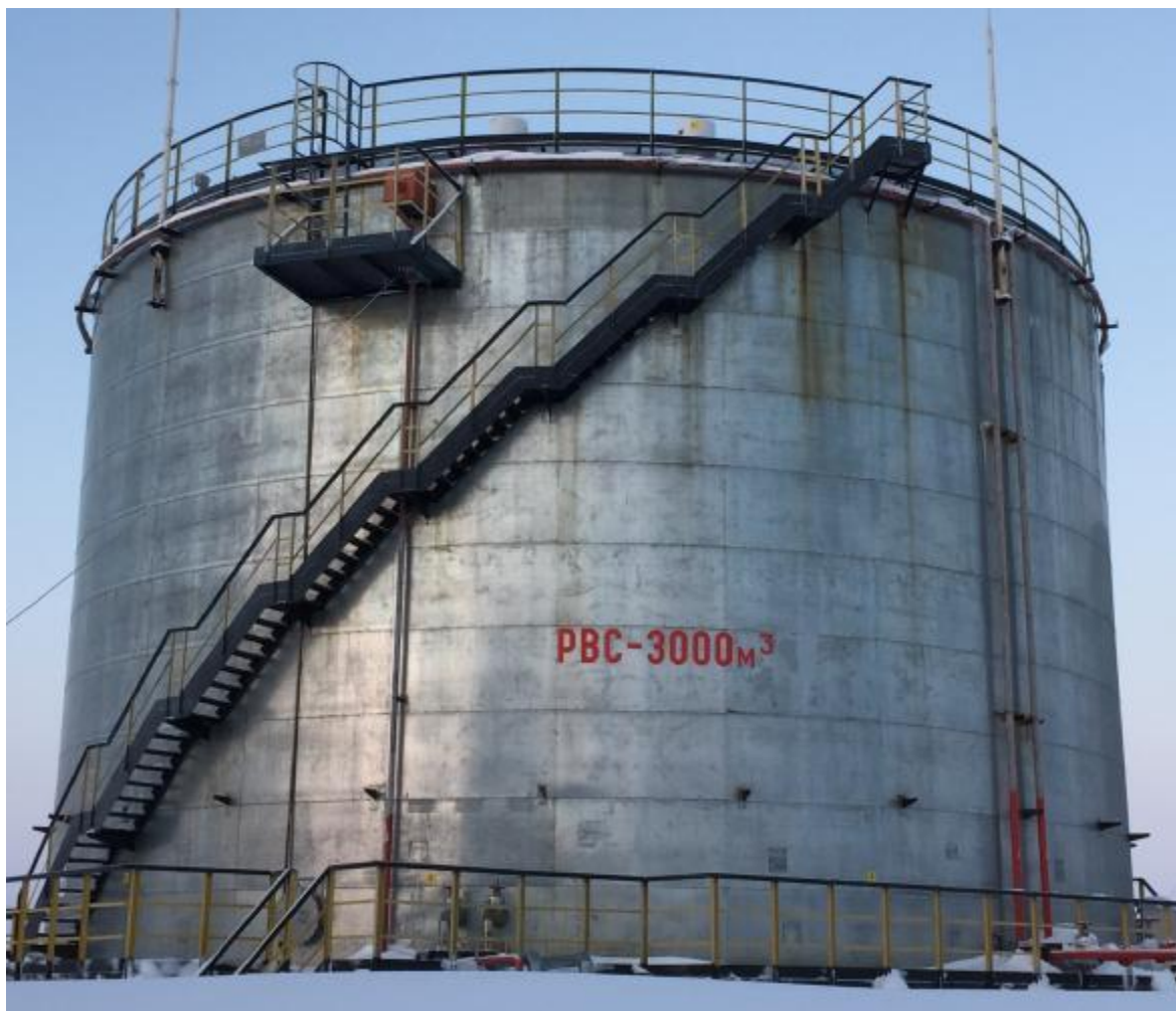
Рисунок 2 - Общий вид резервуара стального вертикального цилиндрического РВС-3000
