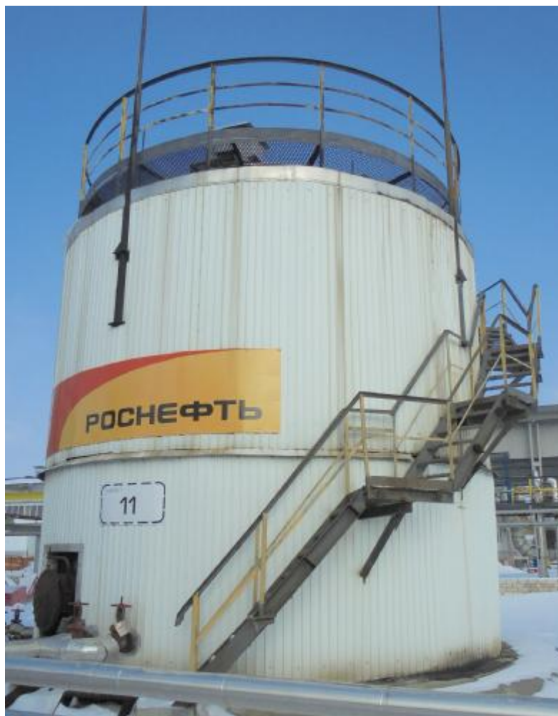
Рисунок 1 – Общий вид резервуара стального вертикального цилиндрического РВС-200
