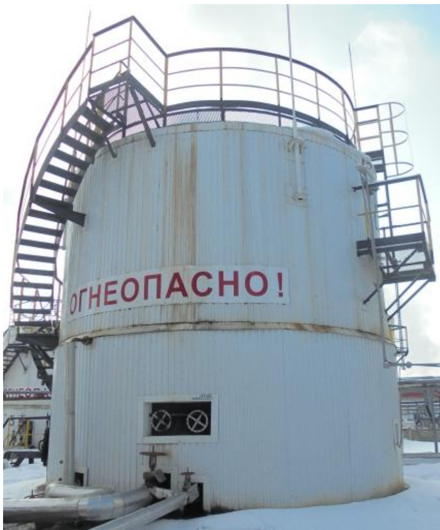
Рисунок 1 – Общий вид резервуара стального вертикального цилиндрического РВС-200
