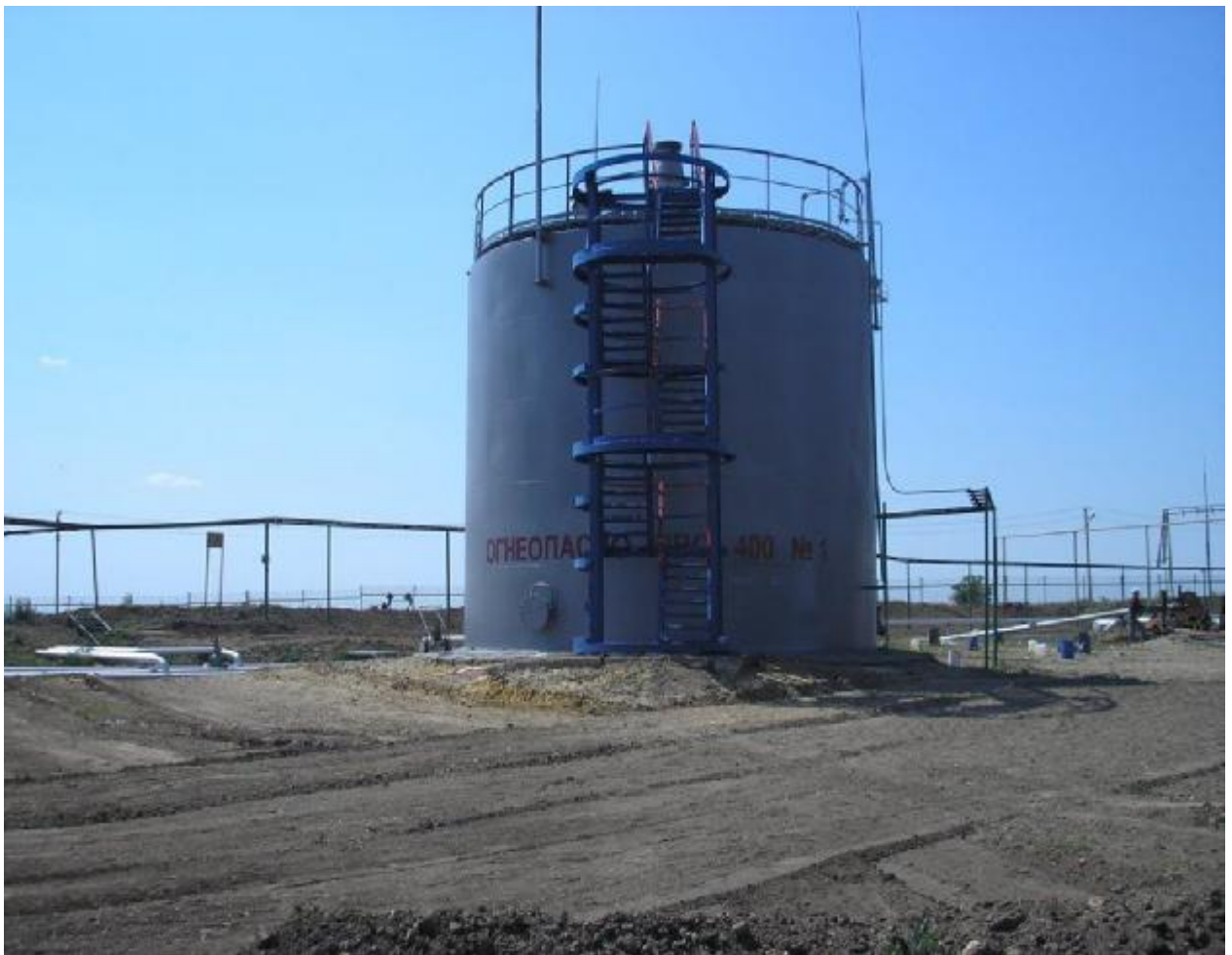
Рисунок 1 - Резервуар вертикальный стальной РВС-400
