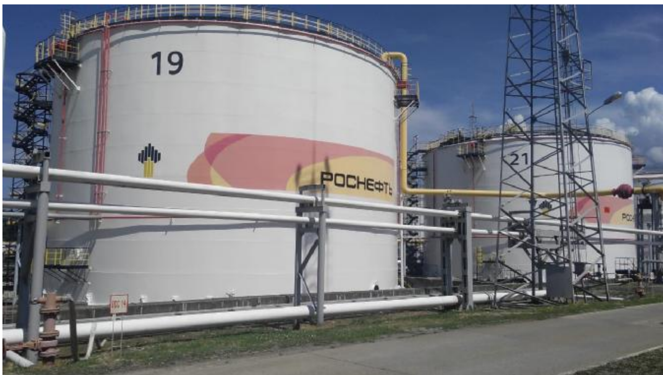
Рисунок 1 - Общий вид резервуаров
