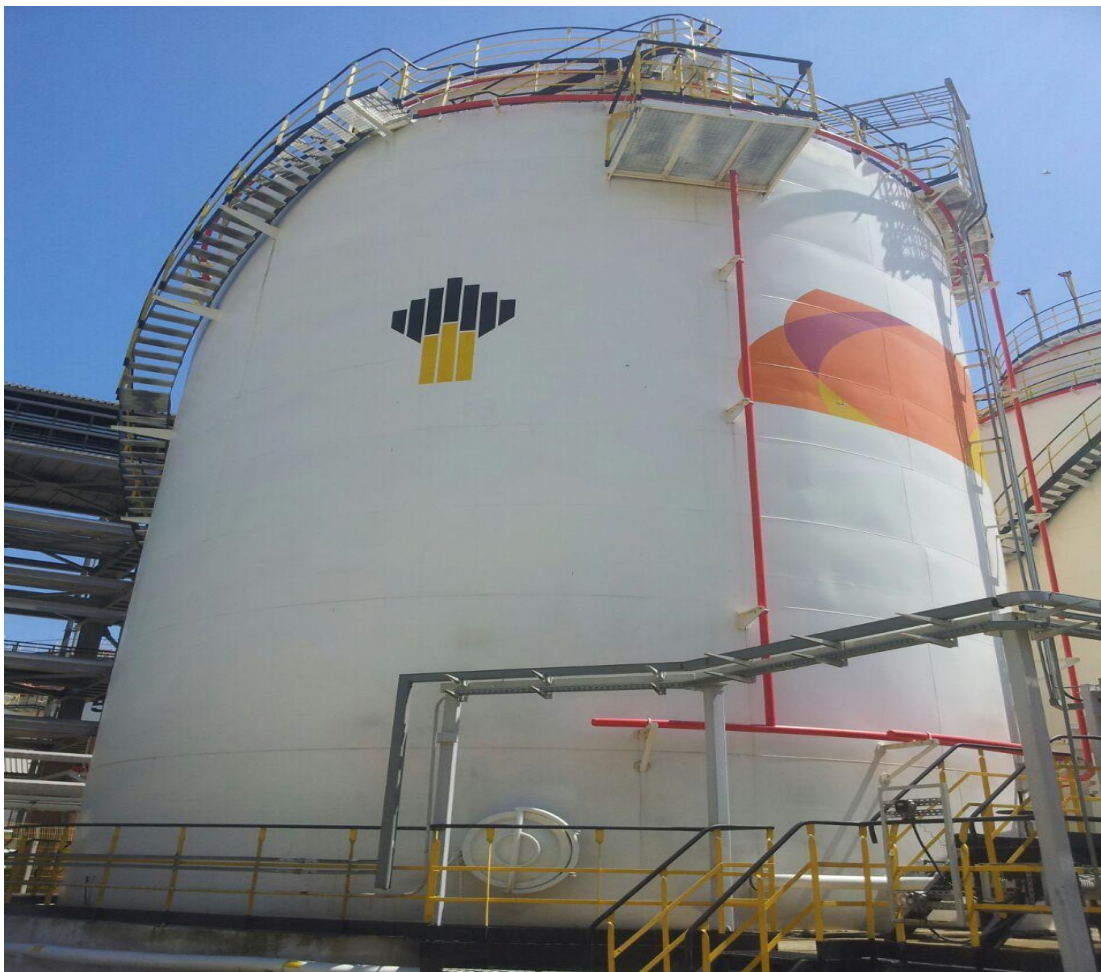
Рисунок 1 - Общий вид резервуаров с защитной стенкой РВСП-1000
