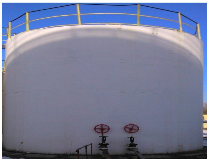
Рисунок 3 – Общий вид резервуара стального вертикального цилиндрического РВС-200
