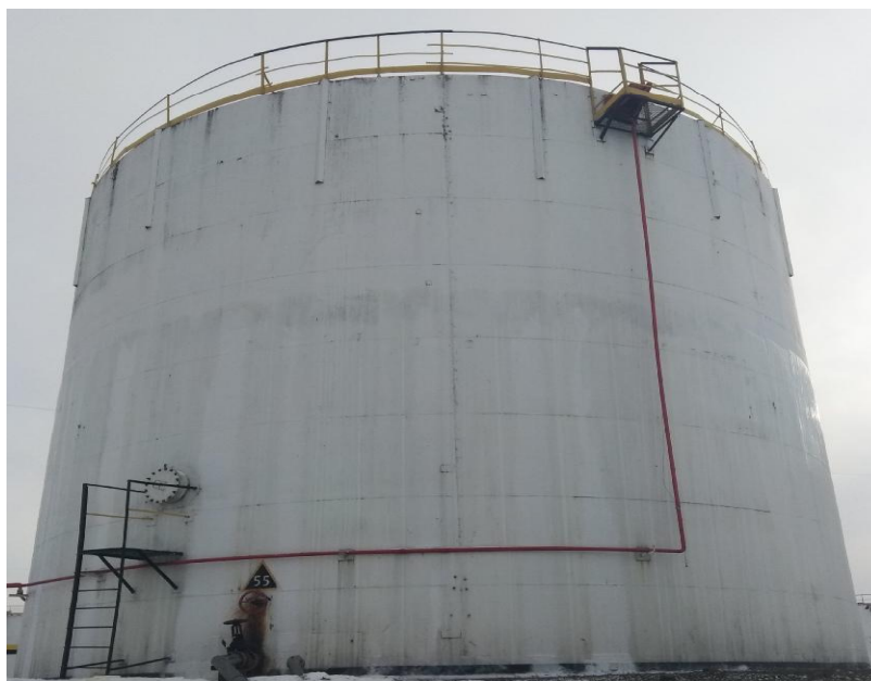
Рисунок 1 – Общий вид резервуара стального вертикального цилиндрического РВСП-2000
