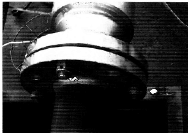
Рисунок А.2 – Пломба поверителя препятствующая демонтажу СРМ с участка измерительного трубопровода
