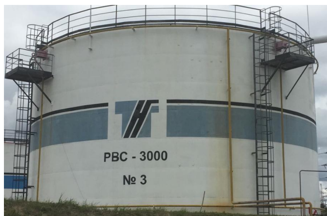
Рисунок 1 - Общий вид резервуара РВС-3000 № 3
