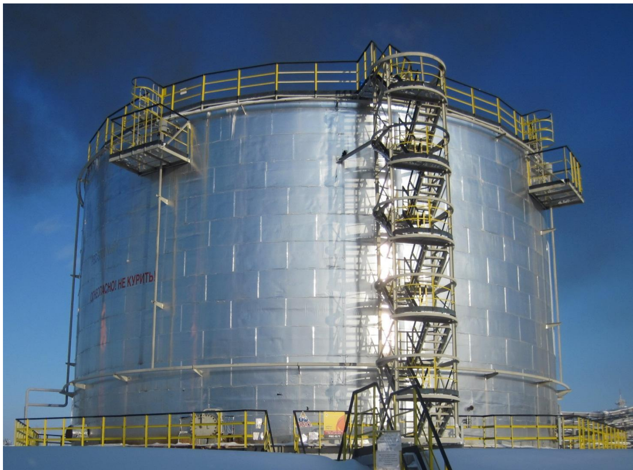
Рисунок 1 - Общий вид резервуара стального вертикального цилиндрического РВС-5000
