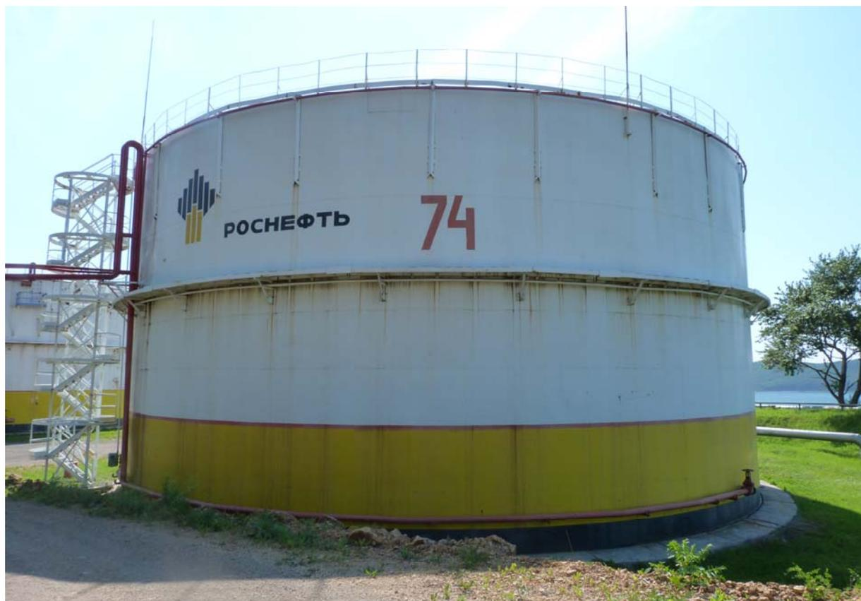
Рисунок 1 - Общий вид резервуара вертикального стального цилиндрического РВС-5000
