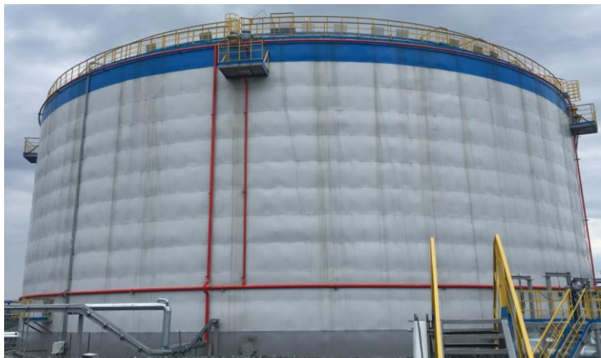
Рисунок 1 – Общий вид резервуаров стальных вертикальных цилиндрических теплоизолированных с понтоном РВСп-30000
