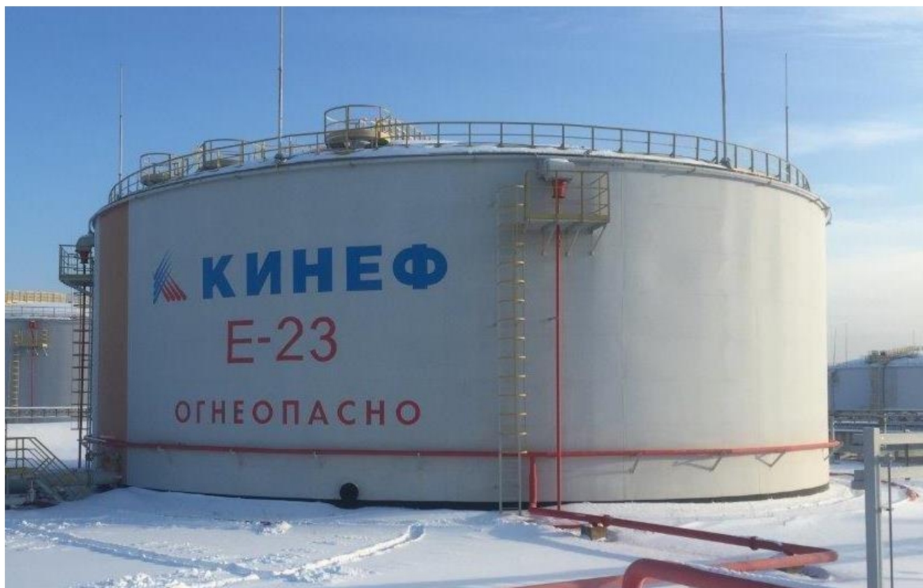
Рисунок 1 - Общий вид резервуара РВСП-10000
