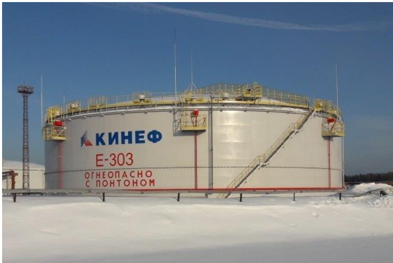
Рисунок 2 - Общий вид резервуара РВСП-20000
