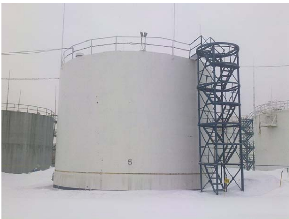
Рисунок 1 - Общий вид резервуара вертикального стального цилиндрического РВС-1000
