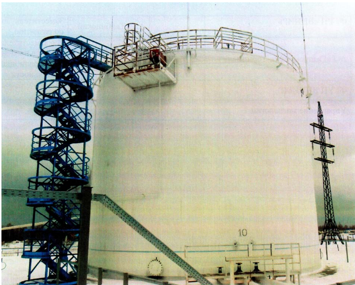
Рисунок 2 - Общий вид резервуара вертикального стального цилиндрического РВС-2000
