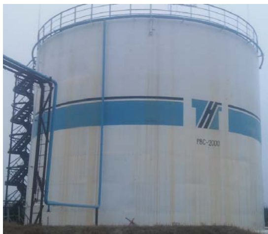
Рисунок 1 - Общий вид резервуара
