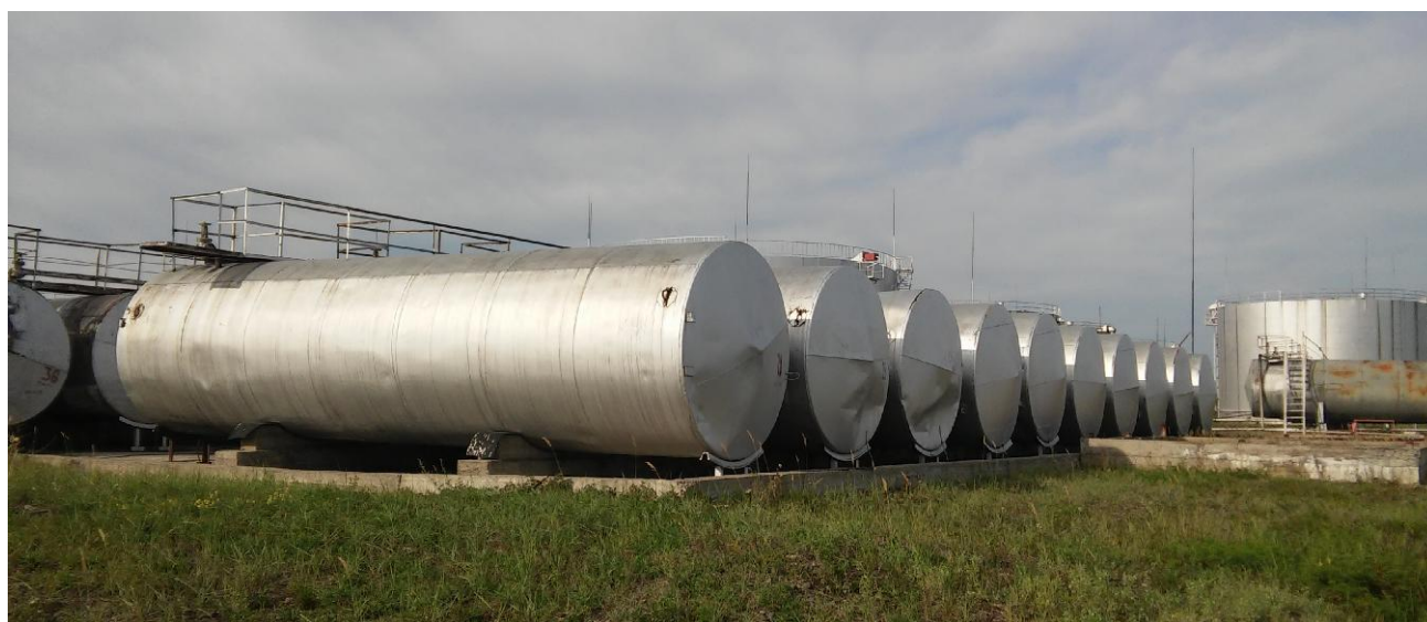
Рисунок 2 - Общий вид резервуара РГС-60
