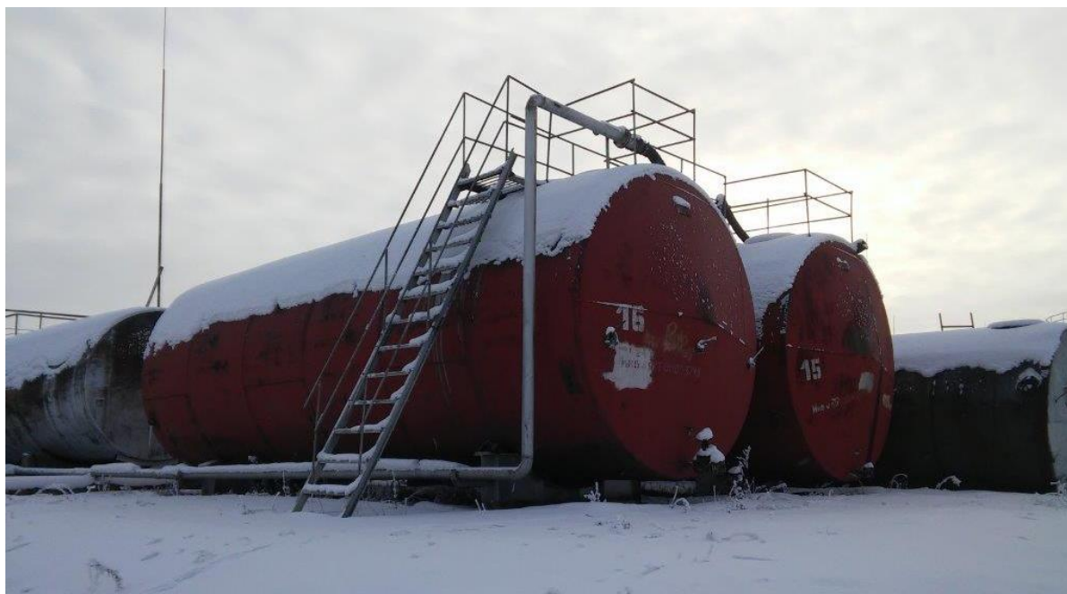
Рисунок 3 - Общий вид резервуара РГС-75
