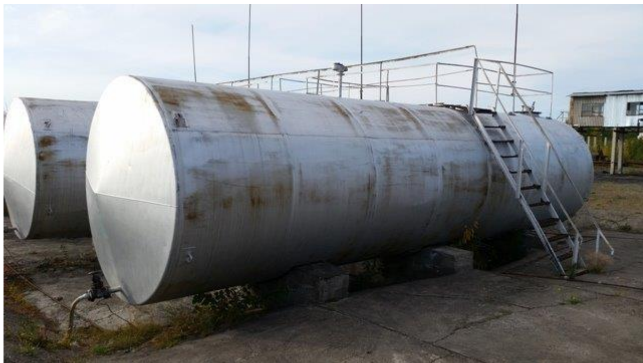
Рисунок 1 - Общий вид резервуара РГС-50
