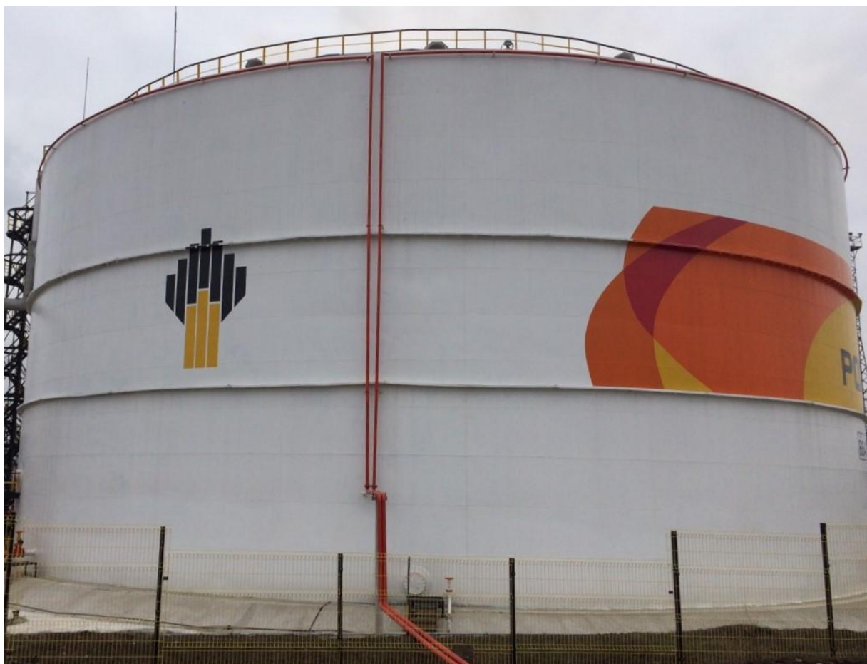
Рисунок 1 - Общий вид резервуара стального вертикального цилиндрического РВС-20000
