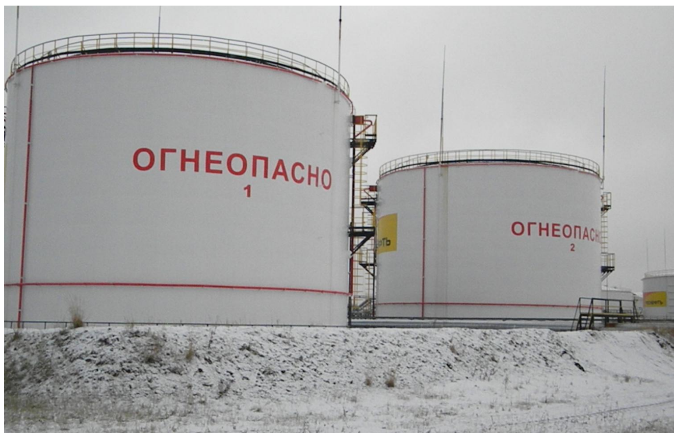
Рисунок 1 - Общий вид резервуаров РВС-5000
