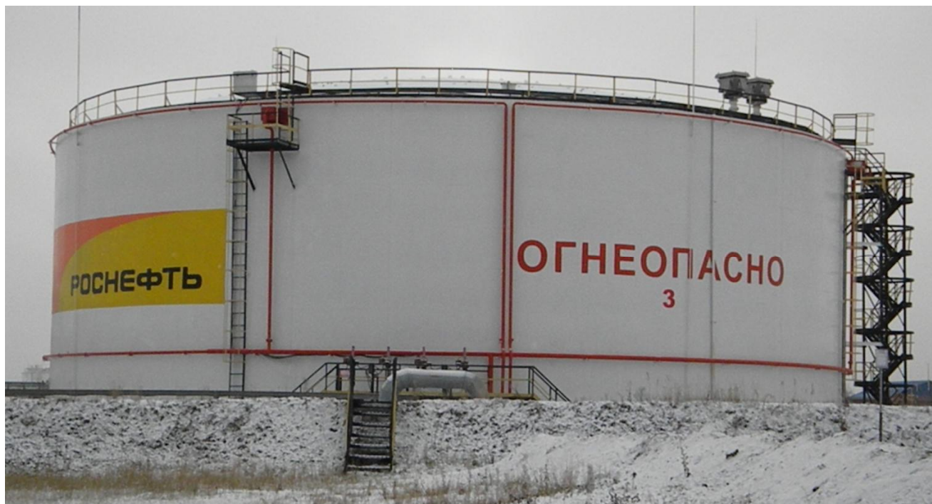
Рисунок 2 - Общий вид резервуара РВС-10000
