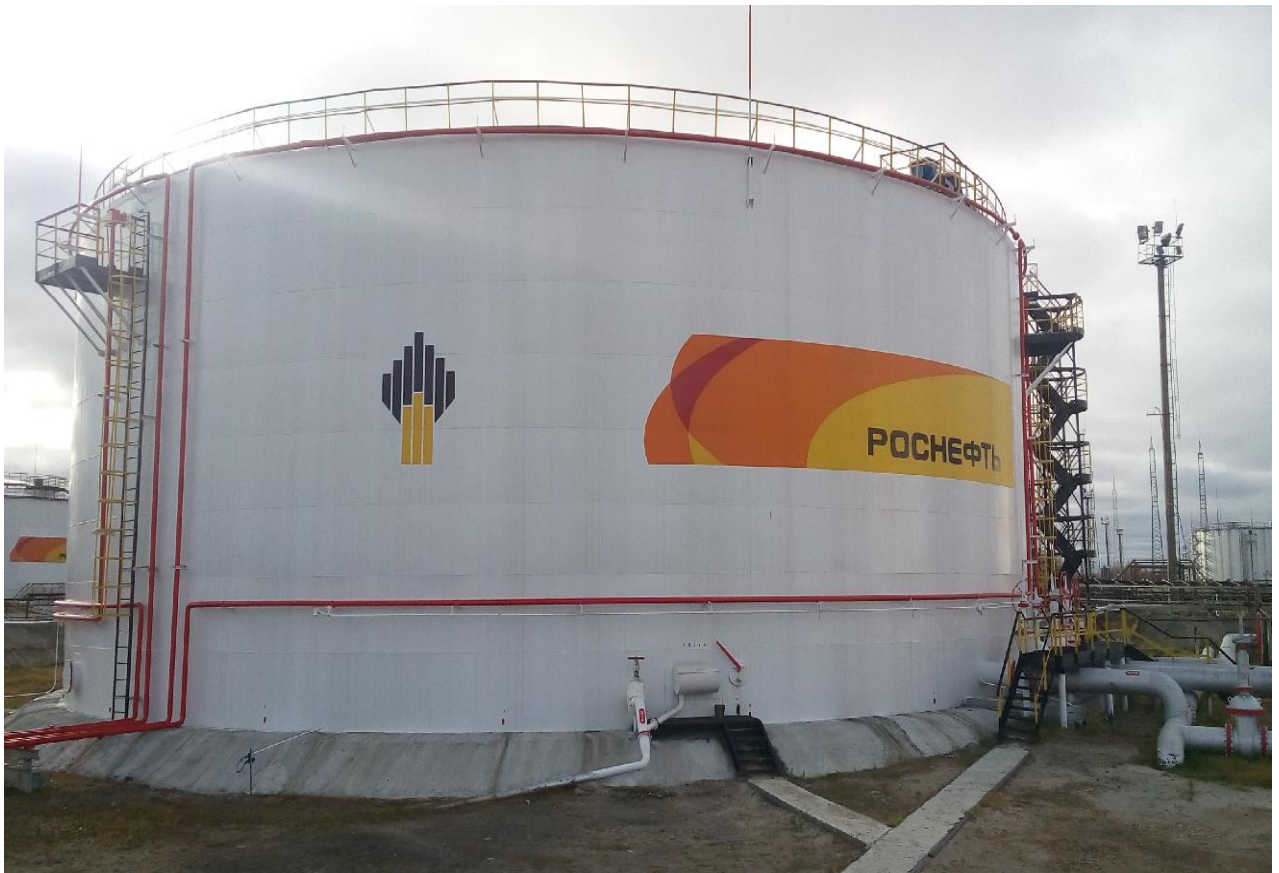
Рисунок 1 - Общий вид резервуара стального вертикального цилиндрического РВС-10000
