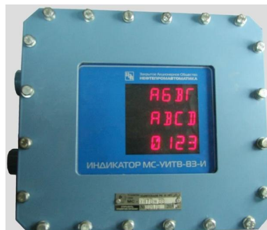
Рисунок 3 - Табло информационное контроллера МС-УИТВ-В3-К (БРИГ-015)
