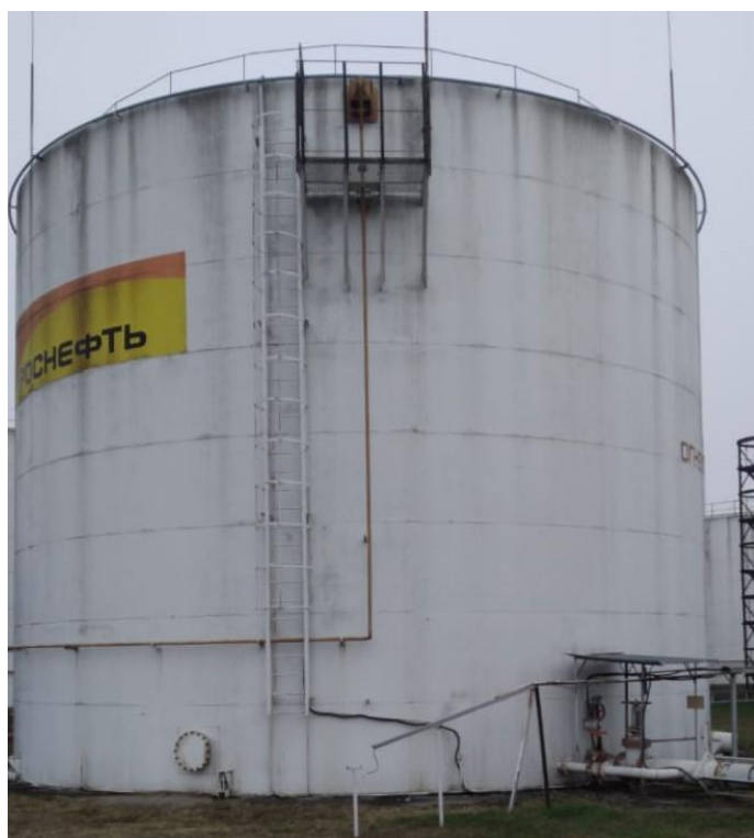
Рисунок 2 – Общий вид резервуаров РВС-2000
