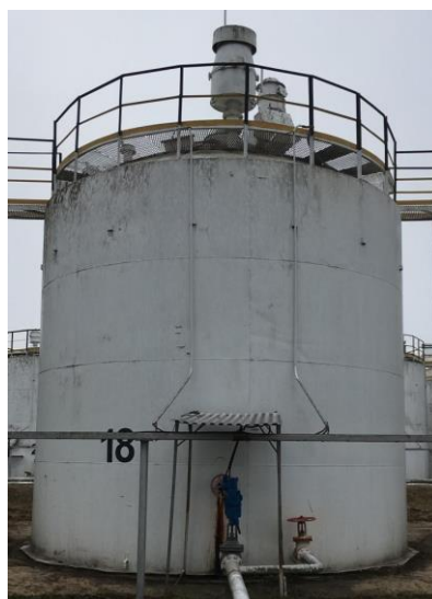
Рисунок 1 – Общий вид резервуаров РВСП-200
