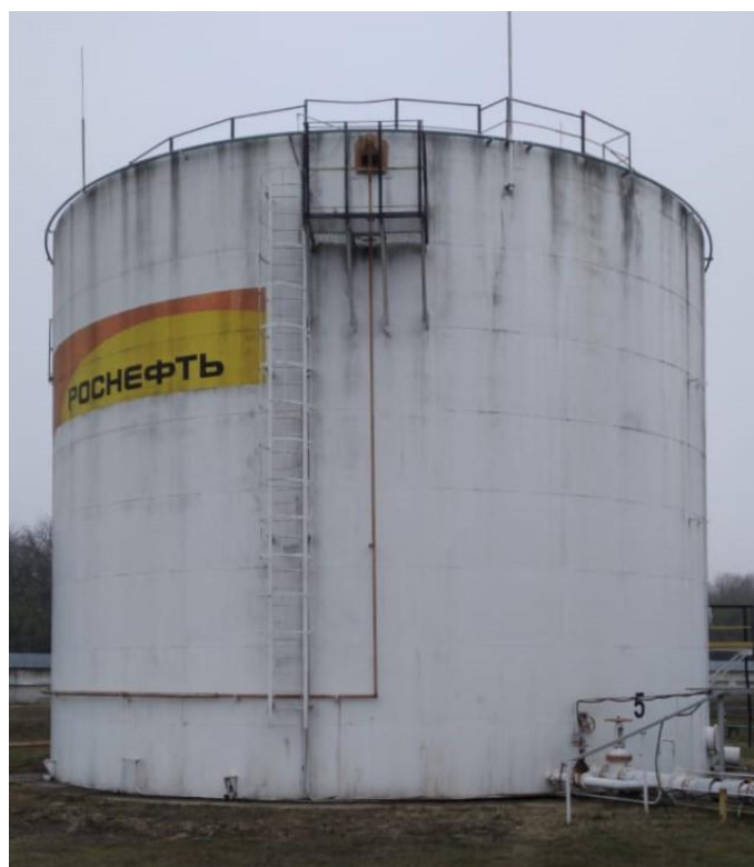
Рисунок 3 – Общий вид резервуаров РВСП-2000
