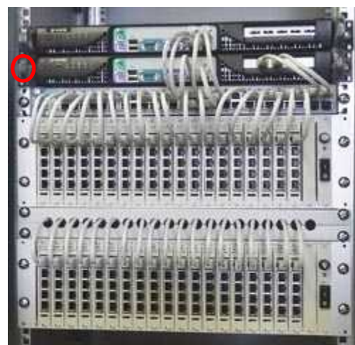
Рисунок 2 - Место пломбирования элемента системы коммутации КАТС «М-200»
