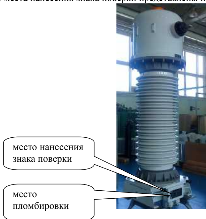
Рисунок 1 - Общий вид трансформатора тока ТОГ - 110
