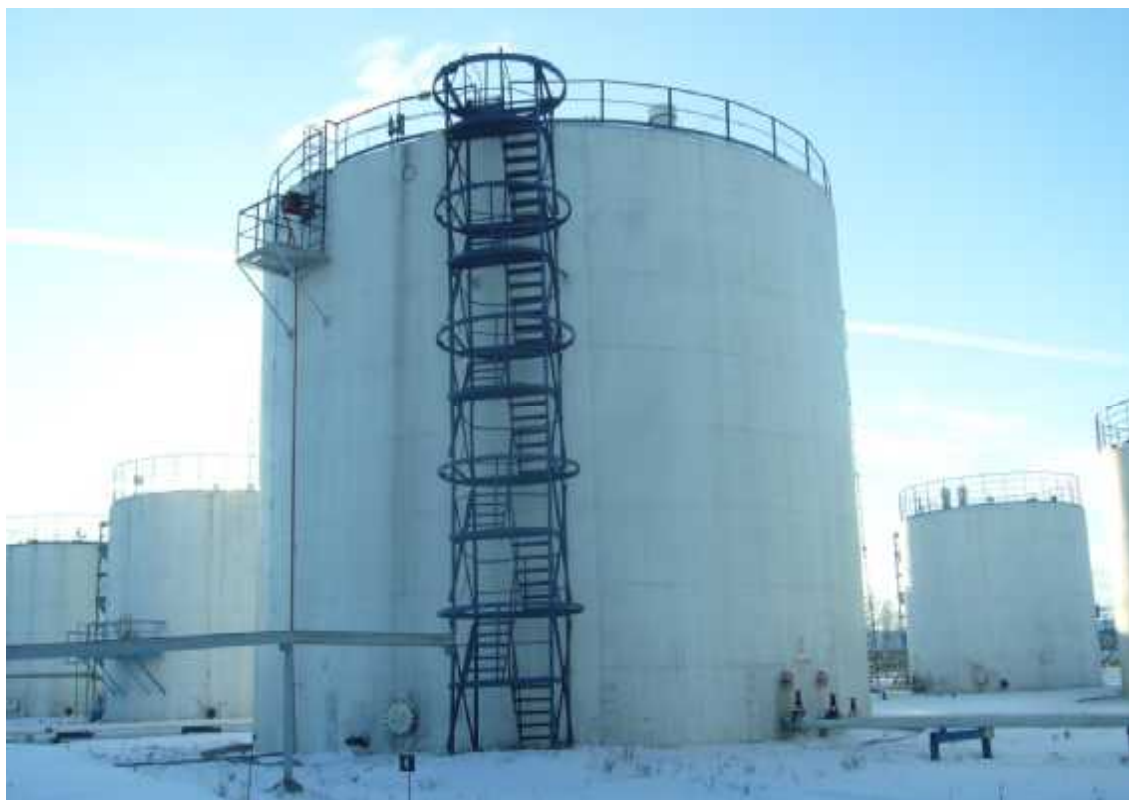
Рисунок 2- Общий вид резервуаров вертикальных стальных цилиндрических РВС-2000
