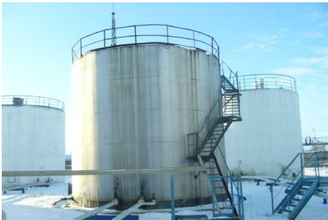
Рисунок 1 - Общий вид резервуаров вертикальных стальных цилиндрических РВС-400
