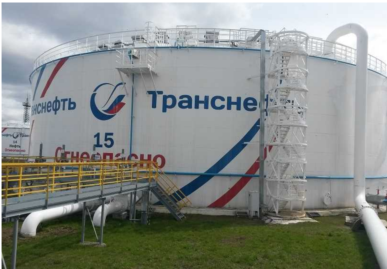
Рисунок 1 - Общий вид резервуара вертикального стального цилиндрического РВС-20000
