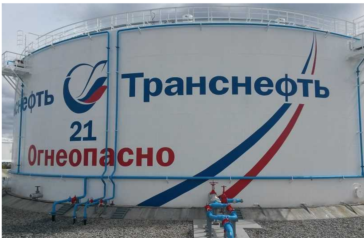
Рисунок 2 - Общий вид резервуара вертикального стального цилиндрического RVSP-20000
