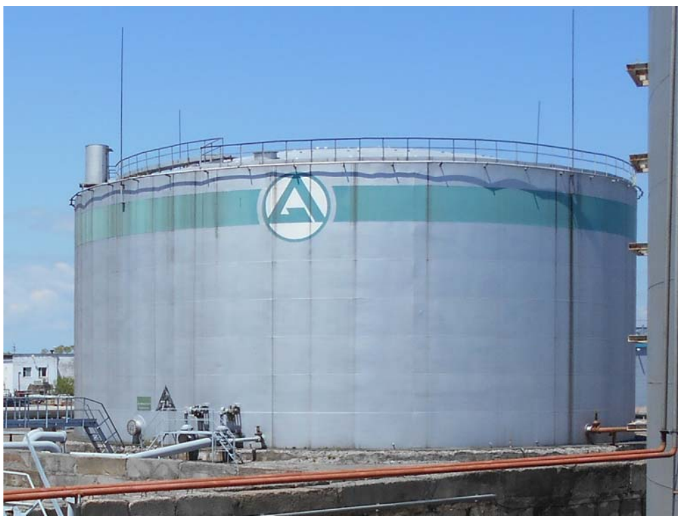
Рисунок 9 - Общий вид резервуара РВС- 8000 № 75
