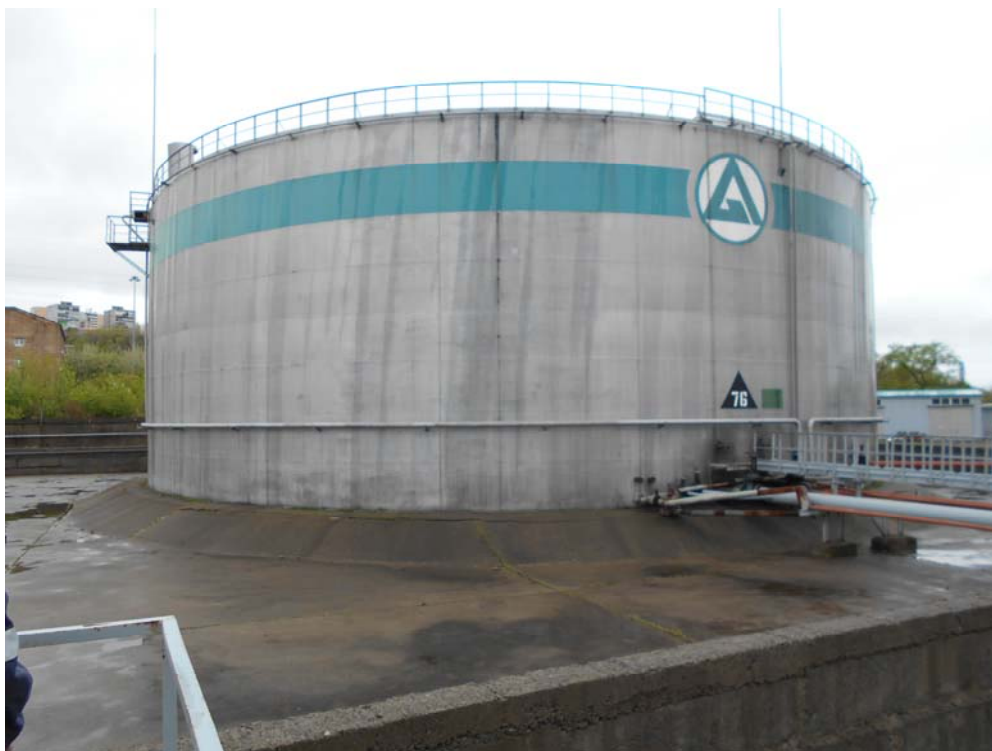
Рисунок 11 - Общий вид резервуара РВС- 10000 № 76
