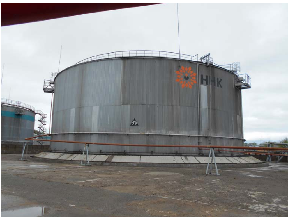
Рисунок 13 - Общий вид резервуара РВС- 10000 № 79
