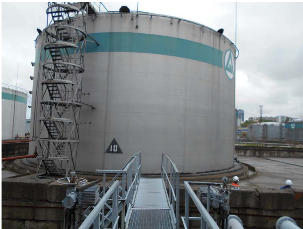
Рисунок 4 - Общий вид резервуара РВСП- 5000 № 10
