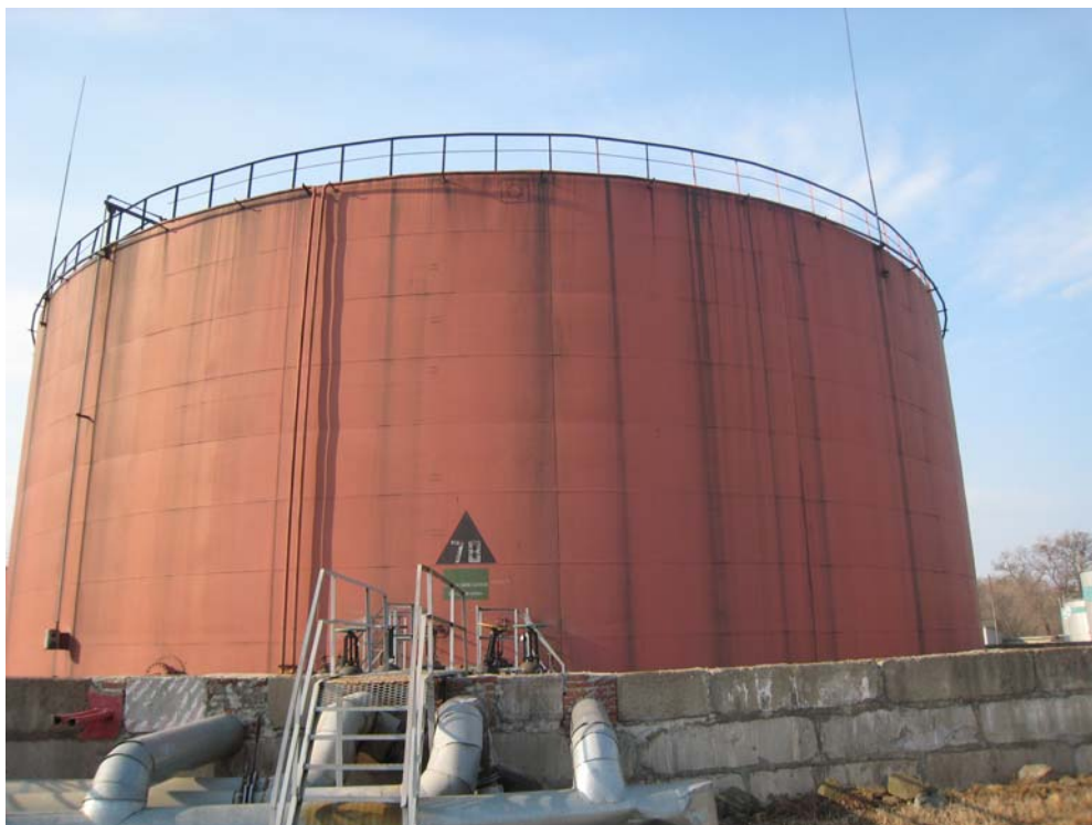
Рисунок 12 - Общий вид резервуара РВС- 10000 № 78
