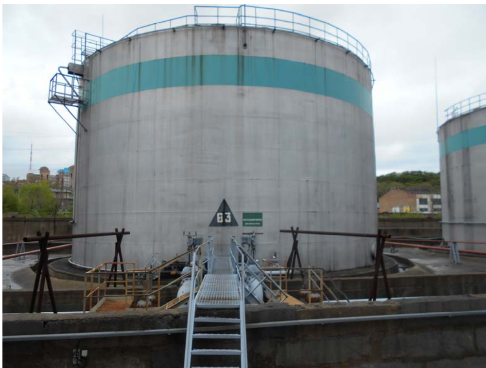
Рисунок 1 - Общий вид резервуара РВС- 4000 № 63
