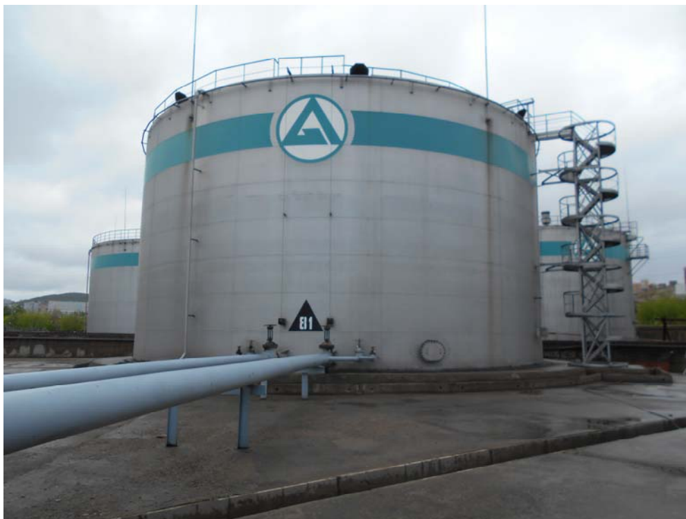
Рисунок 6 - Общий вид резервуара РВСП- 5000 № 81
