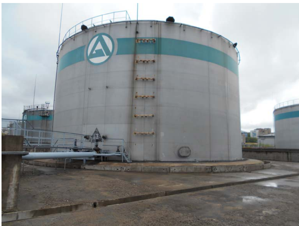
Рисунок 5 - Общий вид резервуара РВСП- 5000 № 13
