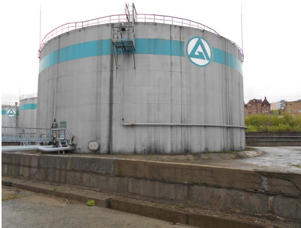
Рисунок 10 - Общий вид резервуара РВС- 8000 № 77
