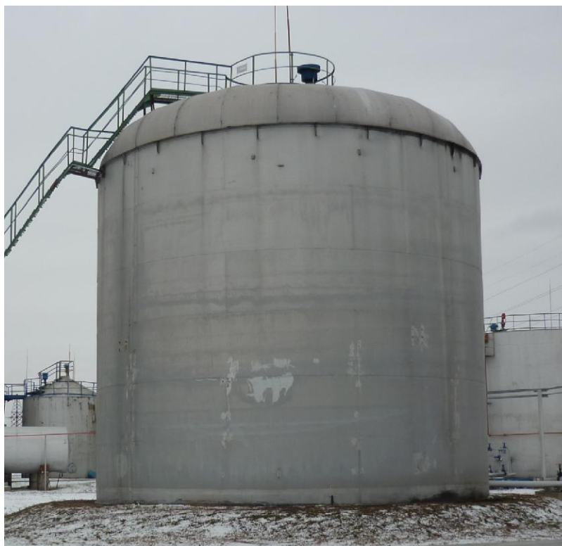
Рисунок 1 - Общий вид резервуара вертикального стального цилиндрического РВС-700
