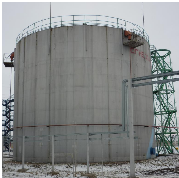
Рисунок 2 - Общий вид резервуара вертикального стального цилиндрического РВС-2000
