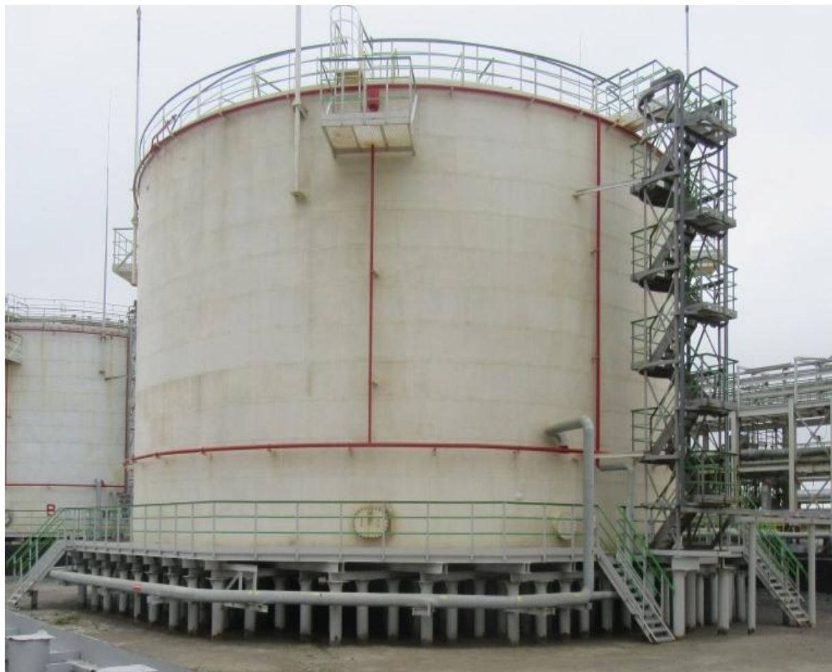
Рисунок 1 - Общий вид резервуара стального вертикального цилиндрического РВС-5000
