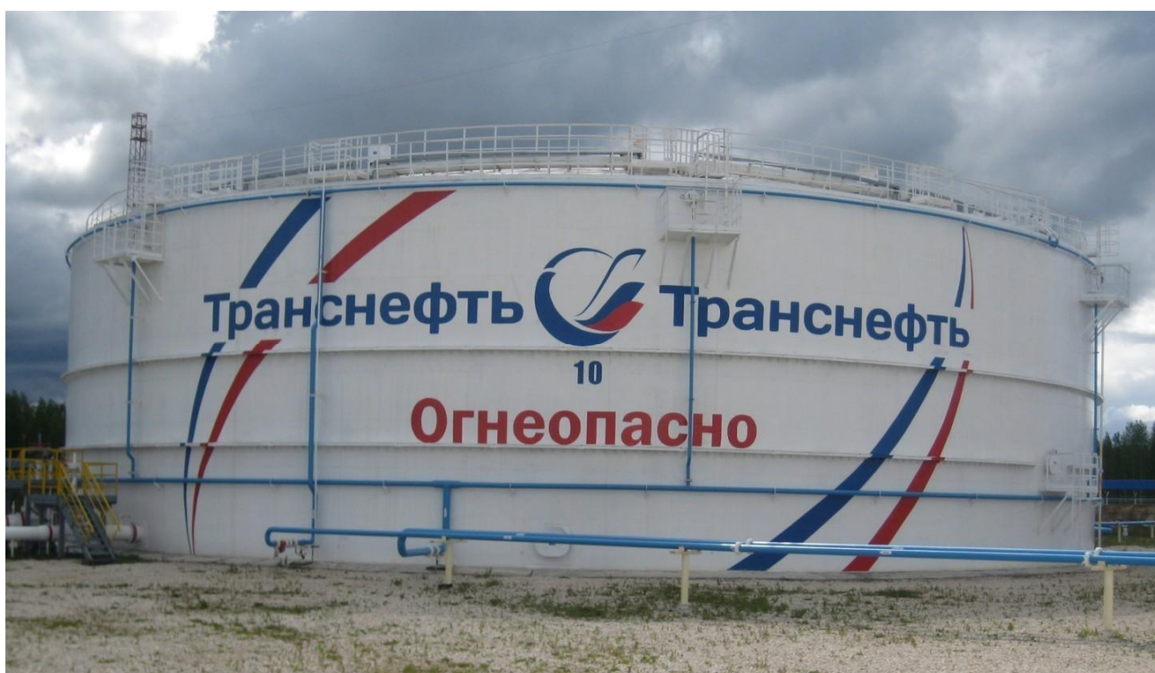
Рисунок 2 - Общий вид резервуара вертикального стального цилиндрического РВСП-20000
