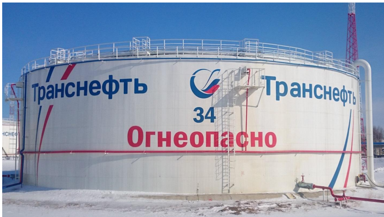
Рисунок 1 - Общий вид резервуара вертикального стального цилиндрического РВС-20000
