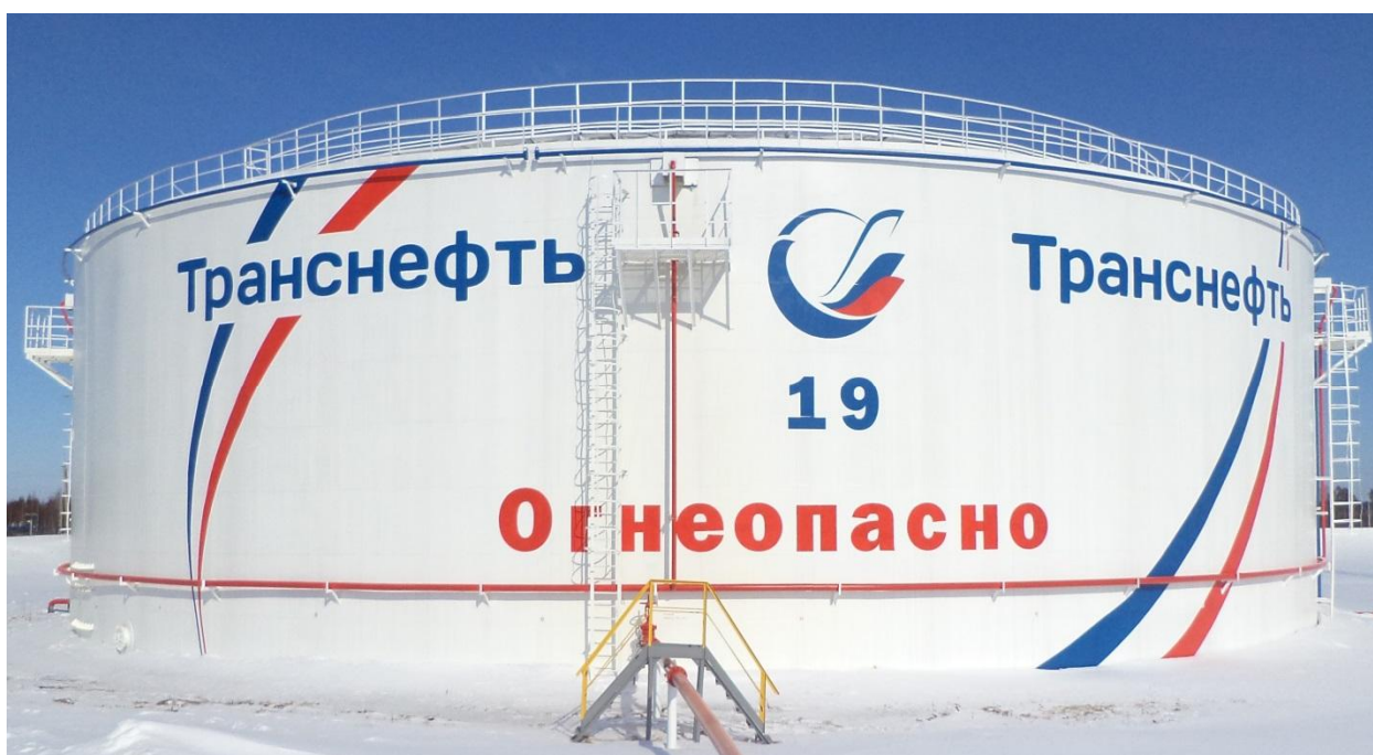
Рисунок 2 - Общий вид резервуара вертикального стального цилиндрического РВСП-20000
