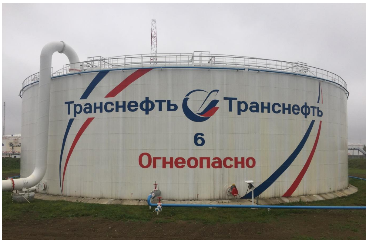
Рисунок 1 - Общий вид резервуара вертикального стального цилиндрического РВС-20000
