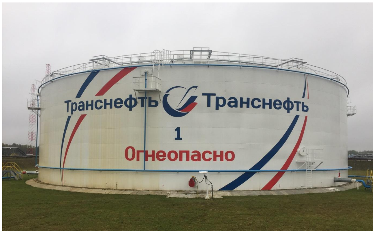
Рисунок 2 - Общий вид резервуара вертикального стального цилиндрического РВСП-20000
