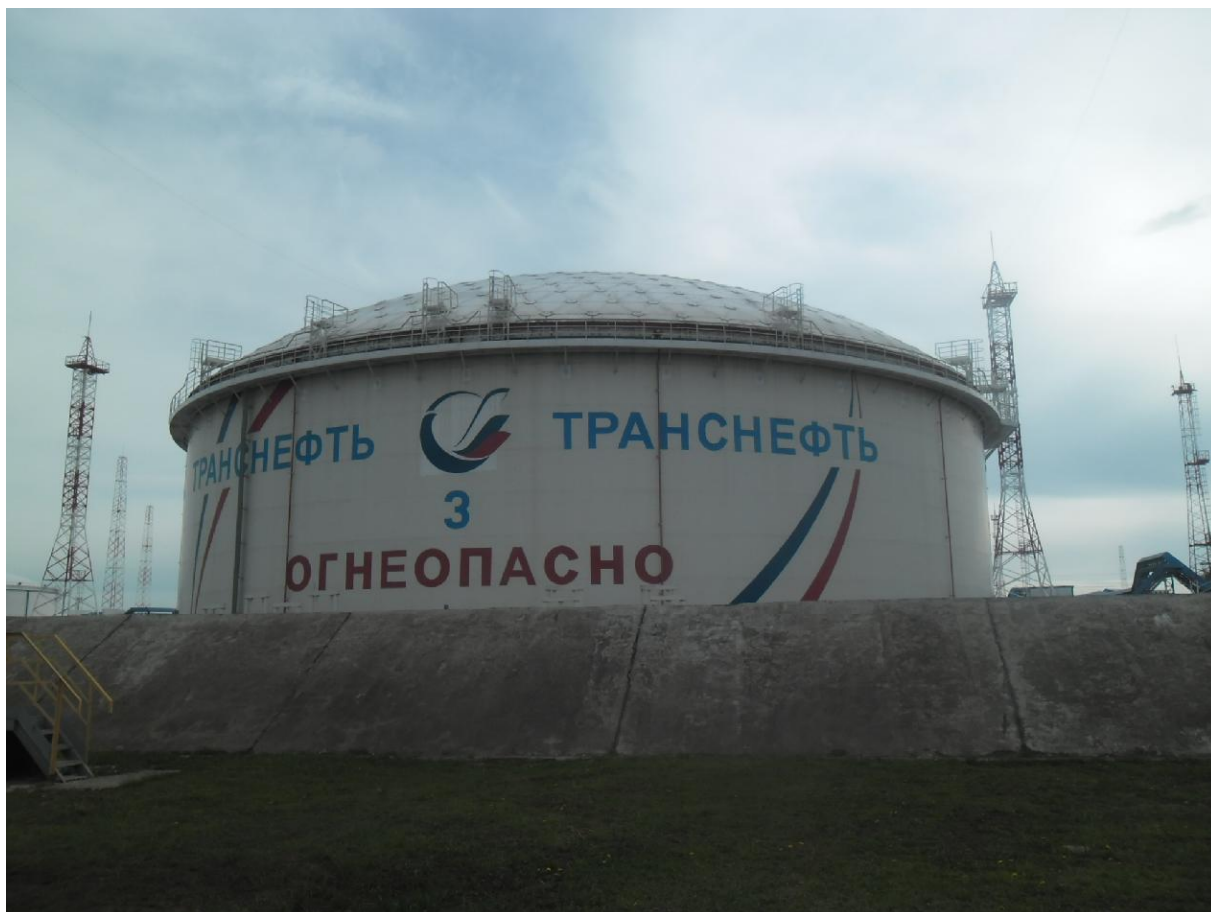
Рисунок 4 - Общий вид резервуара вертикального стального цилиндрического РВСПА-50000
