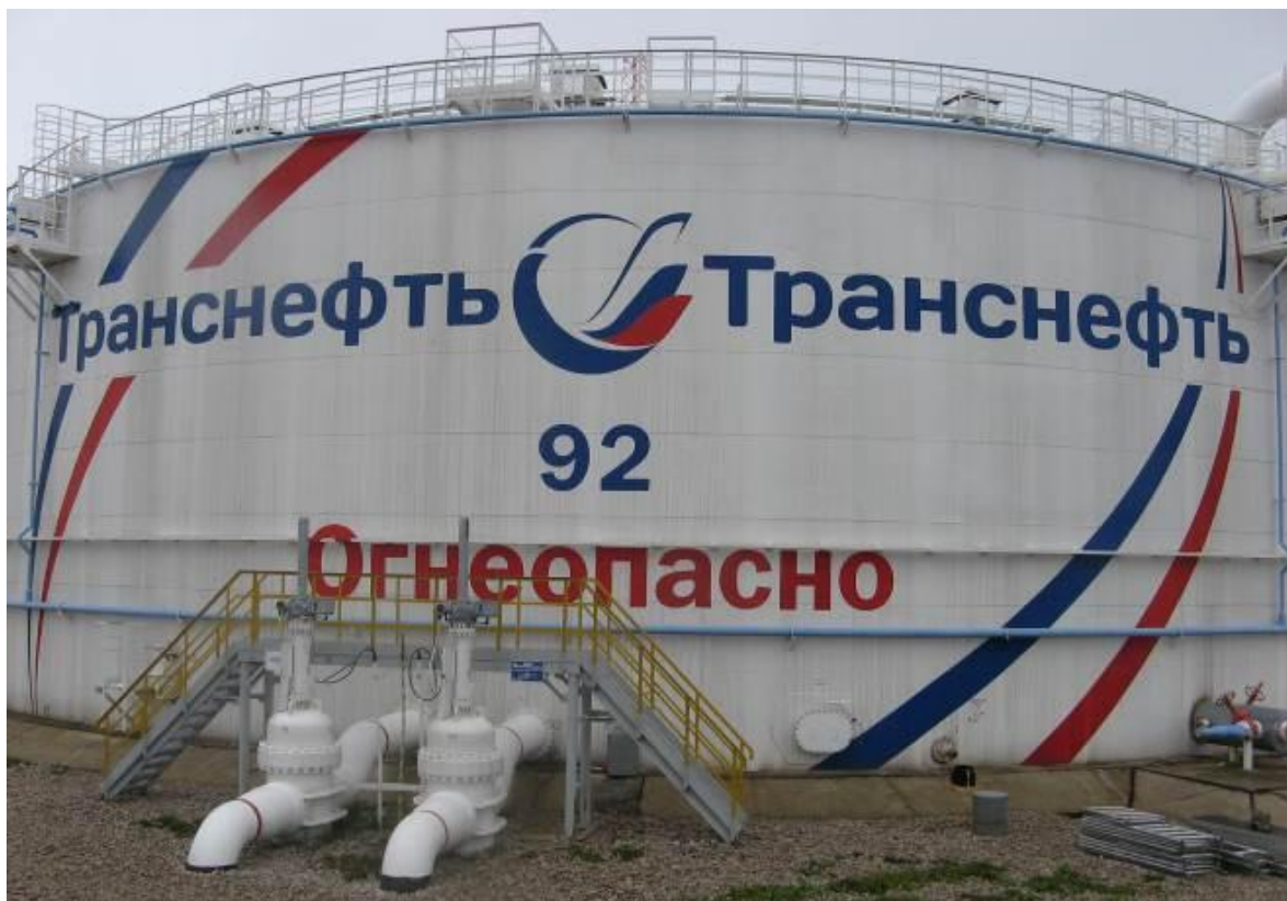
Рисунок 2 - Общий вид резервуара вертикального стального цилиндрического РВС-20000
