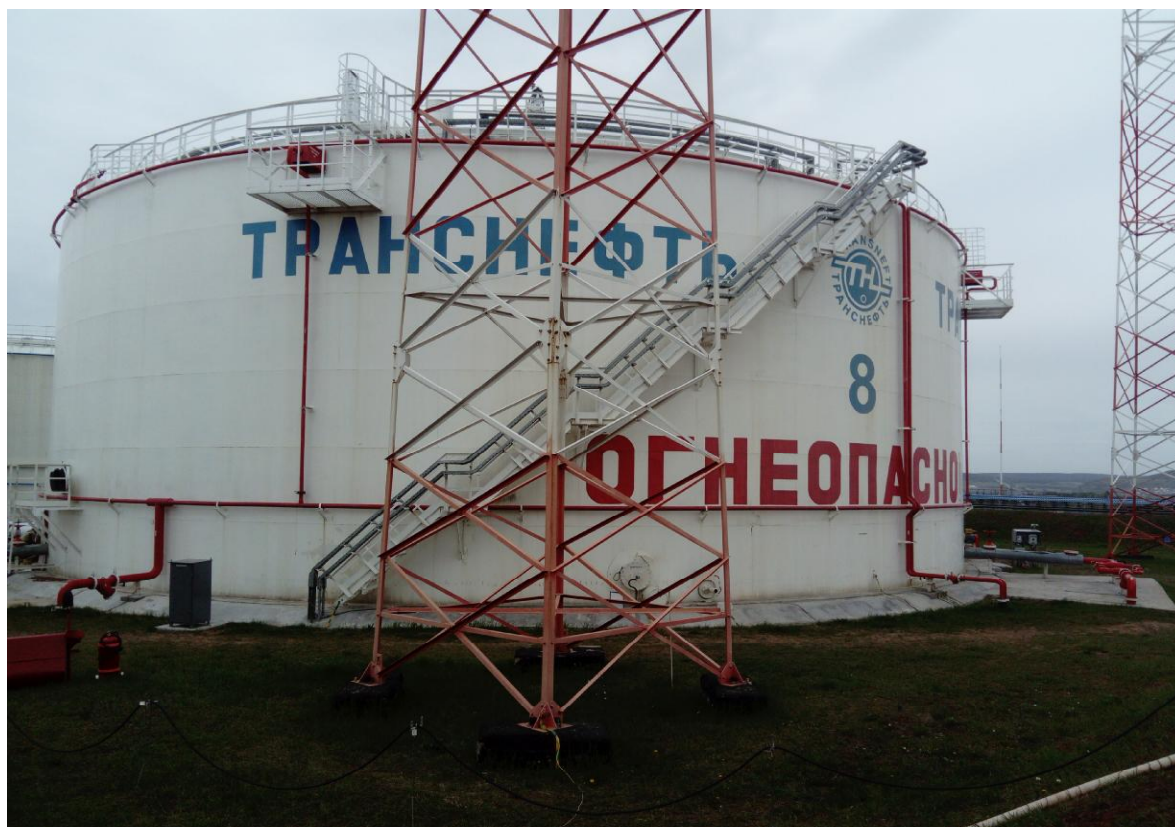
Рисунок 3 - Общий вид резервуара вертикального стального цилиндрического РВСП-10000
