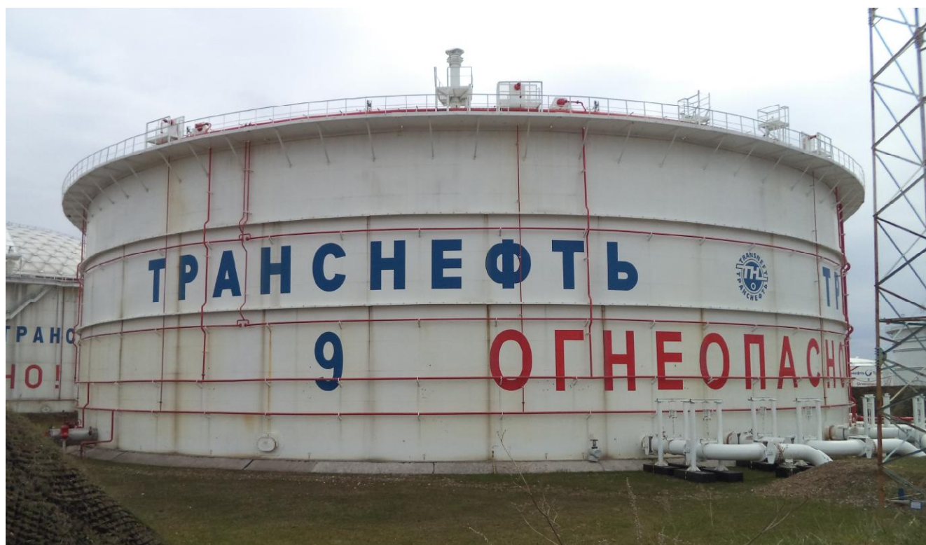
Рисунок 5 - Общий вид резервуара вертикального стального цилиндрического РВСПК-50000
