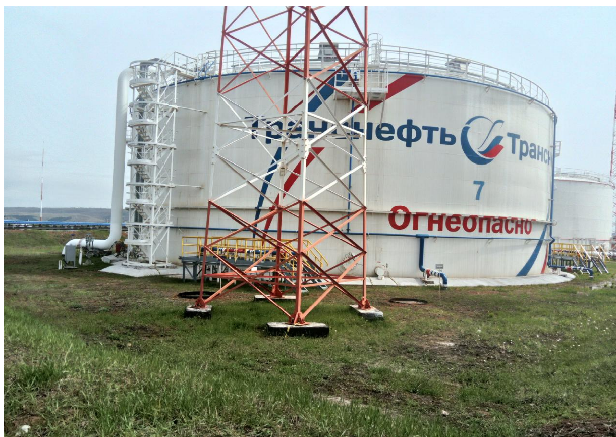
Рисунок 1 - Общий вид резервуара вертикального стального цилиндрического РВС-10000
