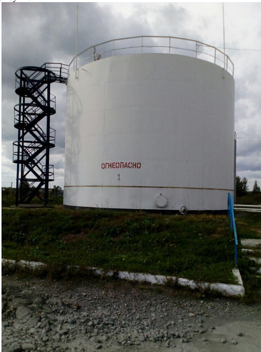
Рисунок 1 – Общий вид резервуара вертикального стального цилиндрического РВС-1000
