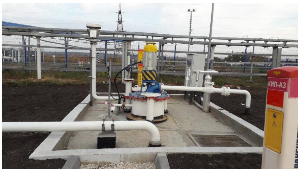
Рисунок 2 – Общий вид надземной части резервуара РГС-8 зав.№ ЕП-1
