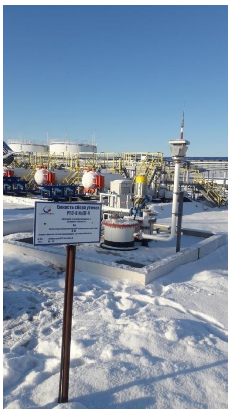
Рисунок 3 – Общий вид надземной части резервуара РГС-8 зав.№ ЕП-4
