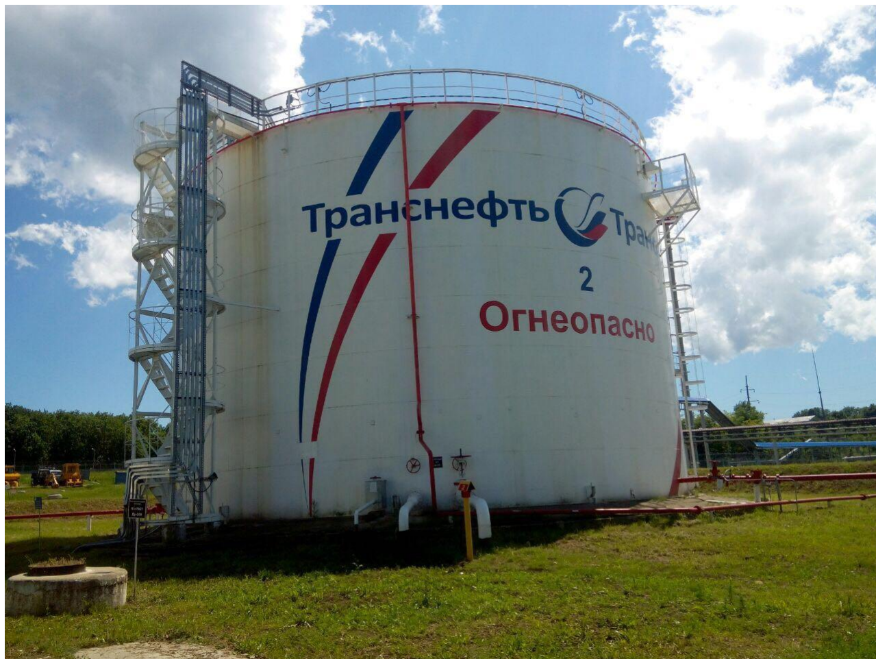
Рисунок 1 - Общий вид резервуара вертикального стального цилиндрического РВС-3000
