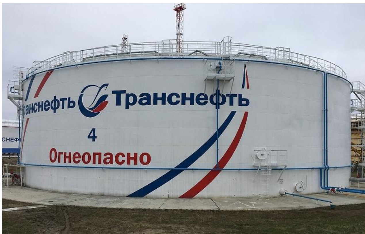
Рисунок 2 - Общий вид резервуара вертикального стального цилиндрического РВСП-20000
