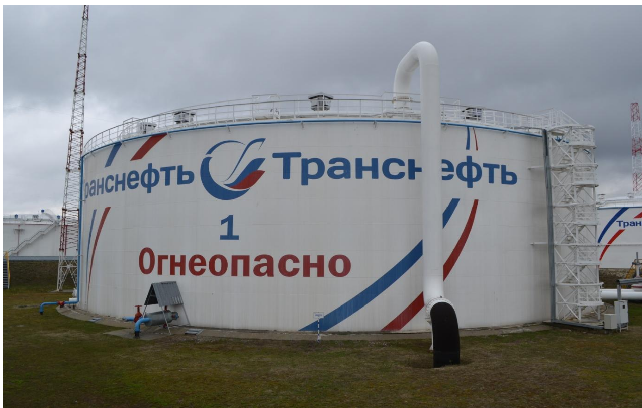
Рисунок 1 - Общий вид резервуара вертикального стального цилиндрического РВС-20000
