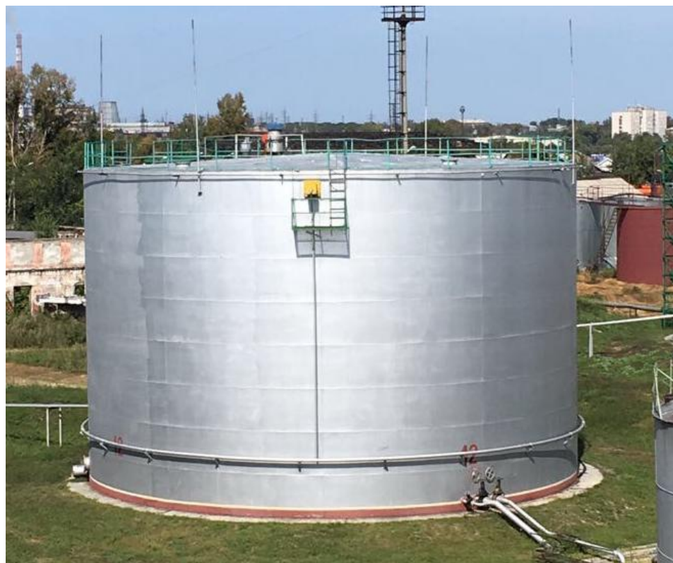
Рисунок 2 - Общий вид резервуара вертикального стального цилиндрического РВС-3000
