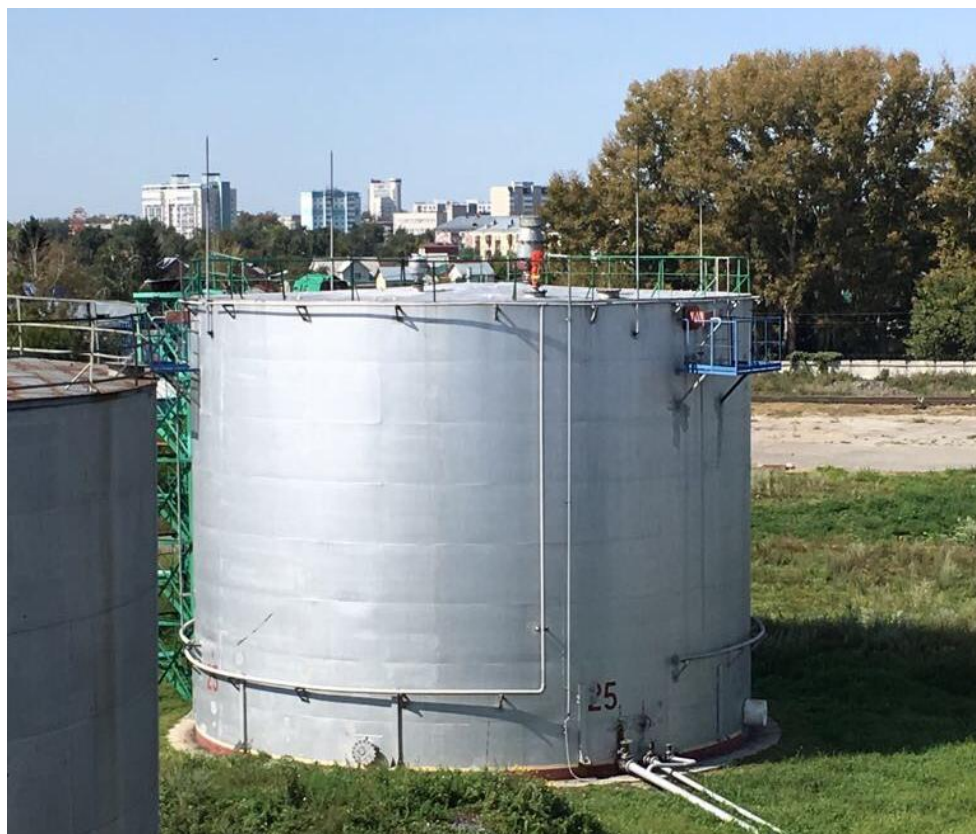
Рисунок 1 - Общий вид резервуара вертикального стального цилиндрического РВС-2000
