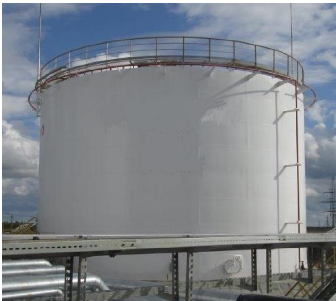
Рисунок 1 - Общий вид резервуара стального вертикального цилиндрического РВС-3000
