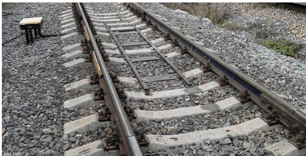
Рисунок 1 - Общий вид ГПУ весов на железобетонных шпалах
