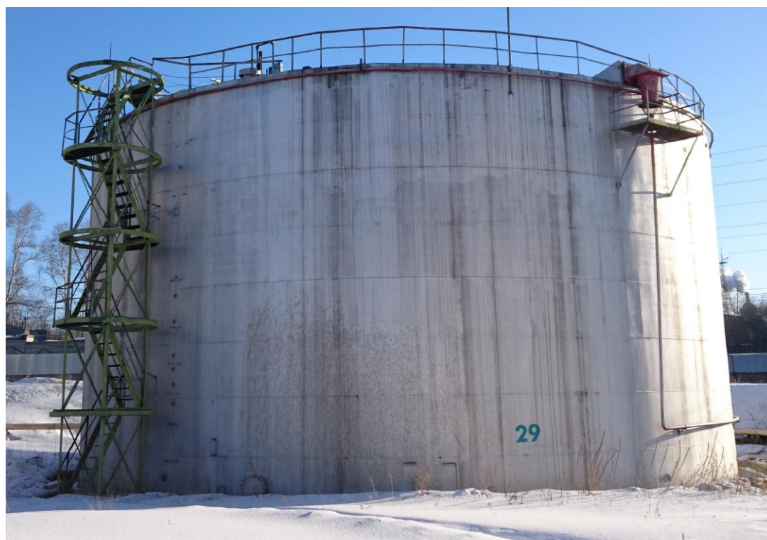
Рисунок 5 - Общий вид резервуара РВС-5000
