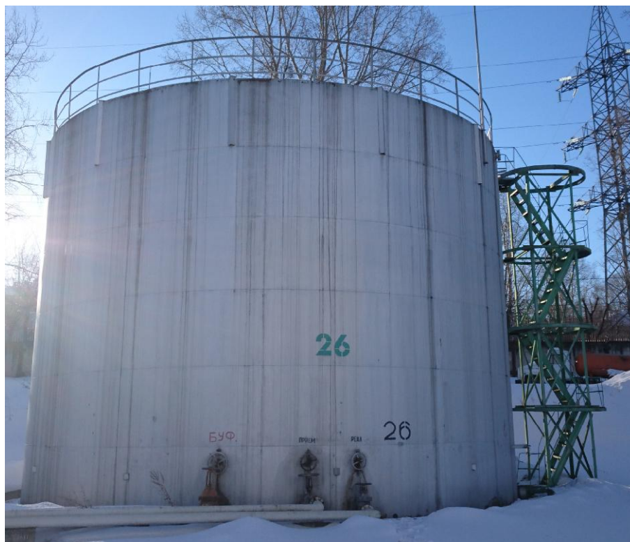
Рисунок 2 - Общий вид резервуара РВС-1000
