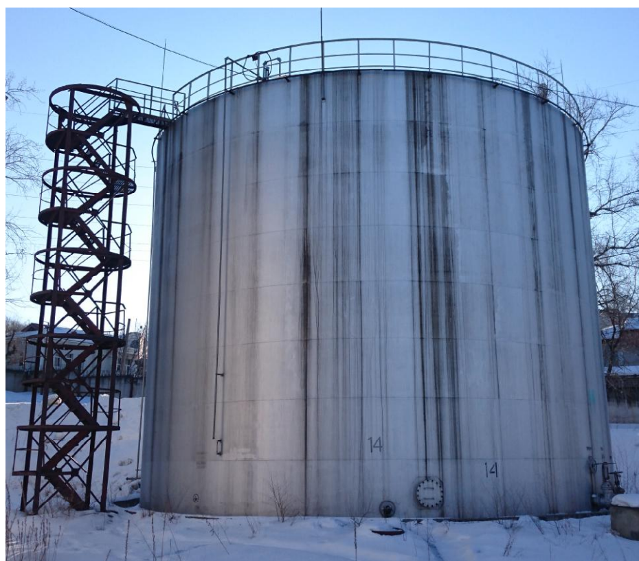
Рисунок 3 - Общий вид резервуара РВС-2000
