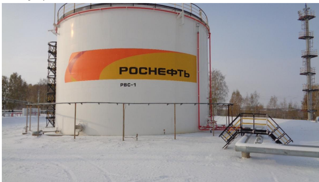
Рисунок 1 - Общий вид резервуара стального вертикального цилиндрического РВС-3000
