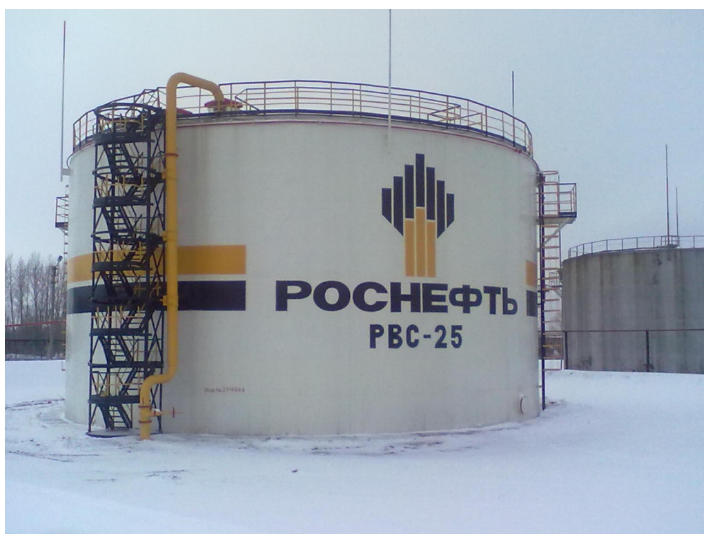
Рисунок 2 - Общий вид резервуара стального вертикального цилиндрического РВС-5000
