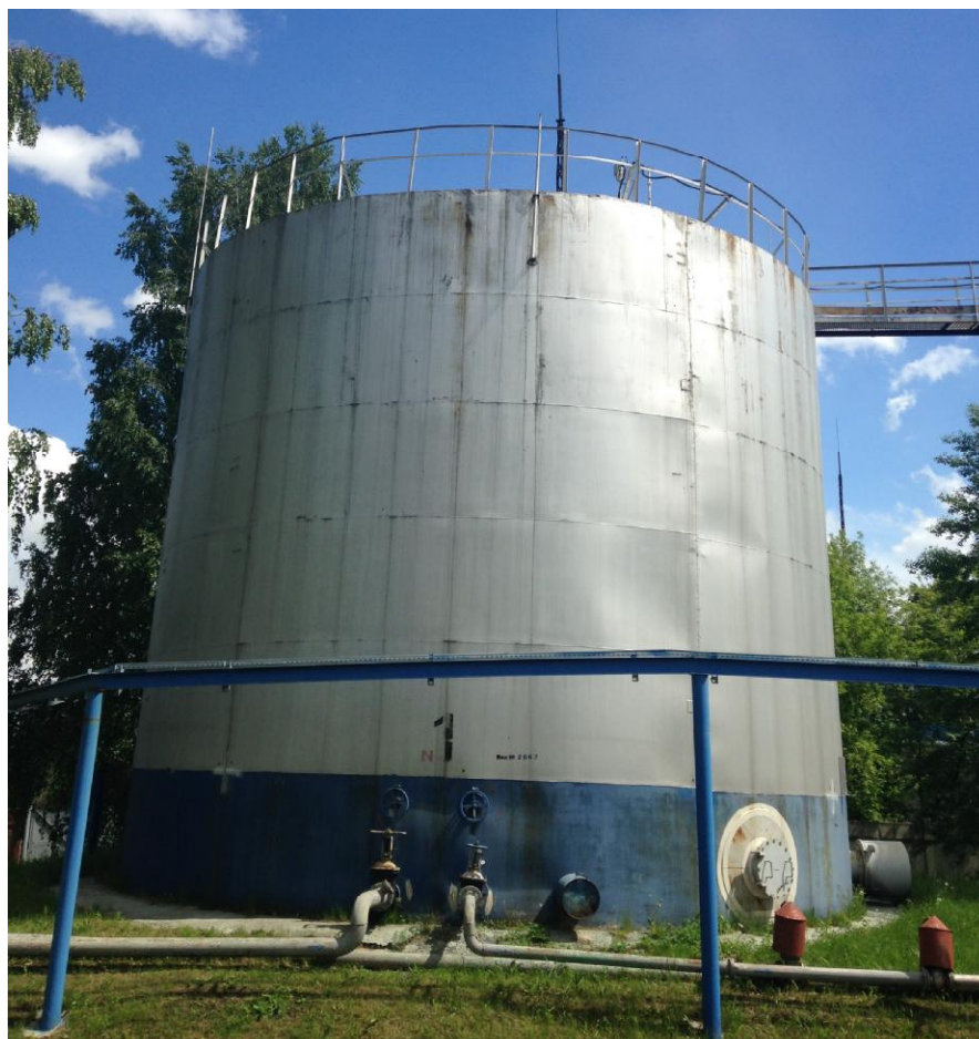
Рисунок 1 - Общий вид резервуара вертикального стального цилиндрического РВС-700
