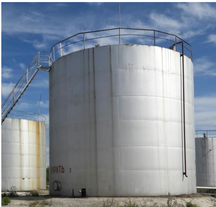
Рисунок 1 - Общий вид резервуара РВС-700
