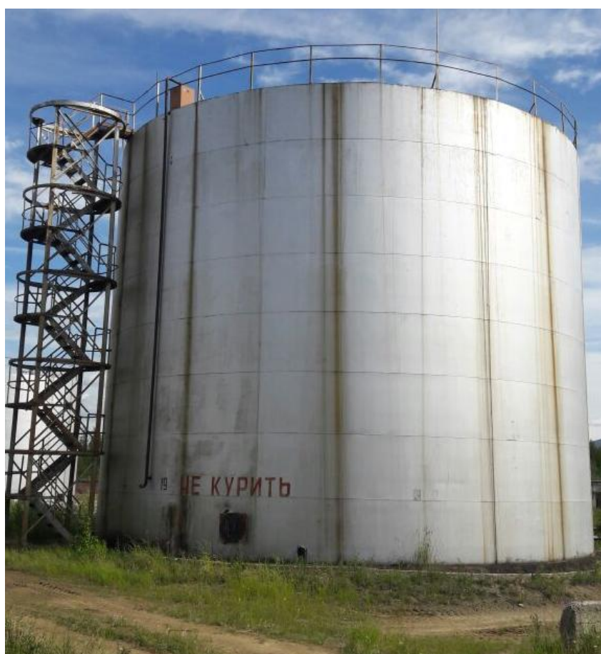
Рисунок 3 - Общий вид резервуара РВС-2000
