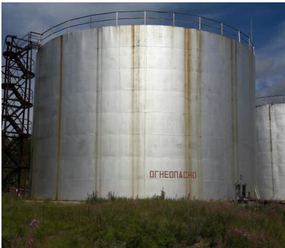
Рисунок 4 - Общий вид резервуара РВС-3000
