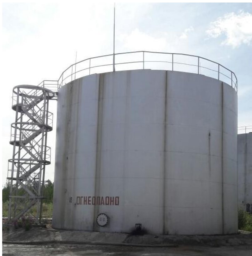
Рисунок 2 - Общий вид резервуара РВС-1000
