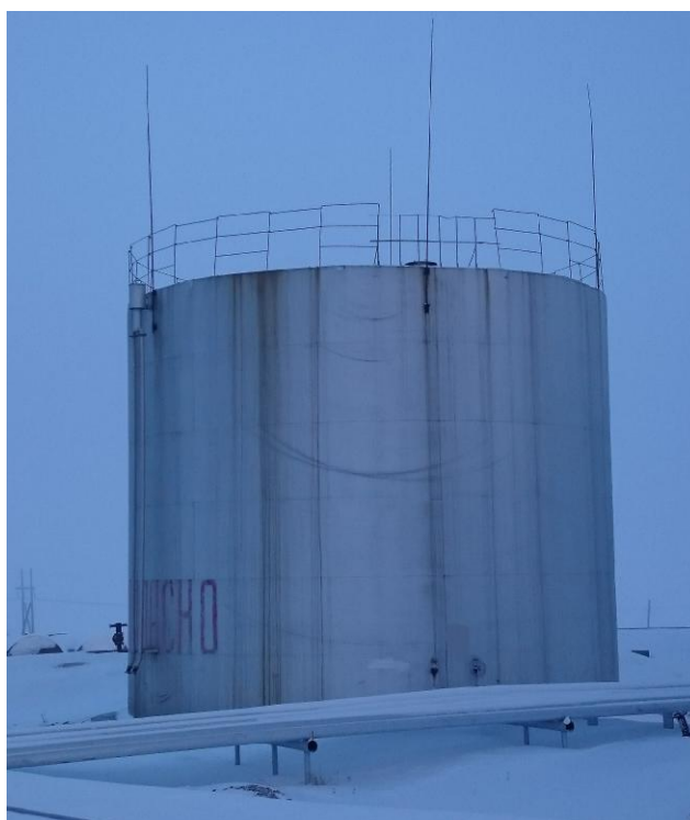
Рисунок 1 - Общий вид резервуара РВС-700
