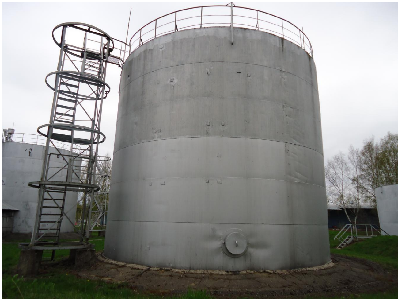
Фото 2 - Общий вид резервуара РВС-700
