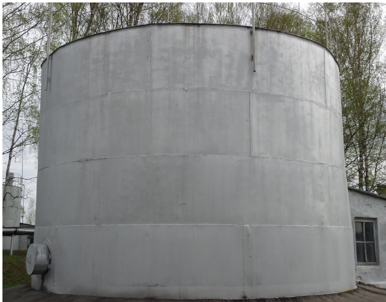
Фото 1 - Общий вид резервуара РВС-300
