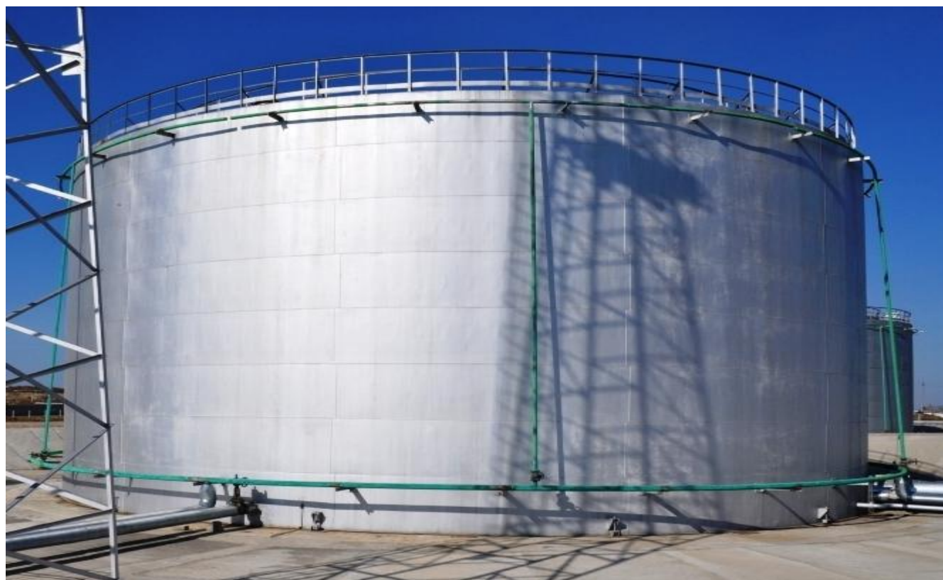
Рисунок 1 - Общий вид резервуара РВС-5000
