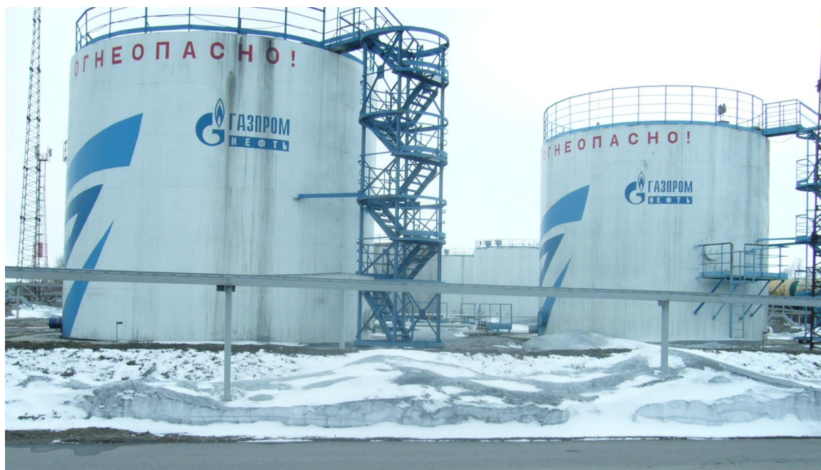
Рисунок 1 – Общий вид резервуаров вертикальных стальных цилиндрических РВС-700, РВСП-700
